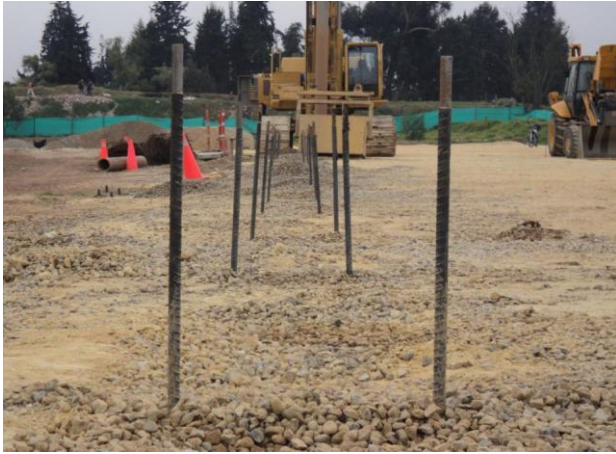
Fotografía No. 5.3.13: Barras de refuerzo de las pilas a tensión que se integran al refuerzo principal de la losa.
