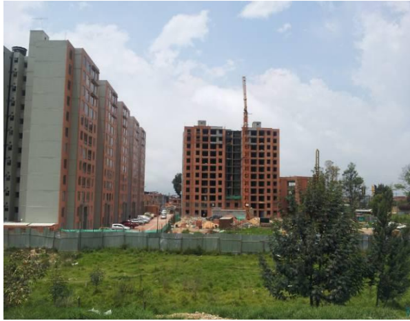
Fotografía No. 5.3. 5: Se aprecian las torres construidas y las que están ya en proceso de acabados.
