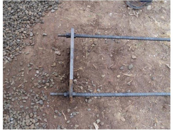
Fotografía No. 5.3.14: Platina de acero del sistema a tensión, a la que acoplan las barras de d=1'' y se ubica en el fondo de la pila.
