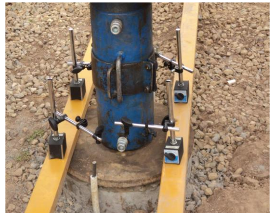
Fotografía No. 5.3.12: Gato hidráulico que ejerce la presión requerida y deformímetros para el registro del comportamiento de las deformaciones tanto en carga como en descarga.
