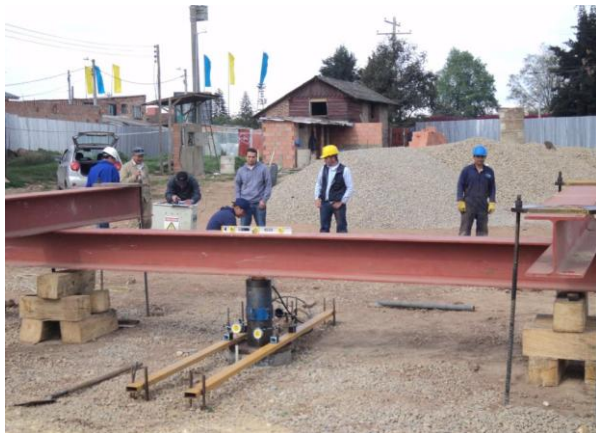
Fotografía No. 5.3.11: Montaje para la prueba de carga sobre una pila en la zona Z.
