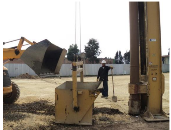
Fotografía No. 5.3.8: Vertido del agregado en el balde con minicargador para su vaciado en la tolva.
