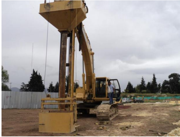
Fotografía No. 5.3.9: Proceso de izaje del balde para su vaciado en la tolva acoplada al equipo.
