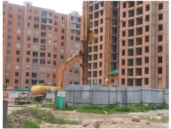
Fotografía No. 5.3.2: Proceso constructivo de las Torres 9 y 10 de la Zona A. Nótese la máquina empleada para la construcción de las pilas.
