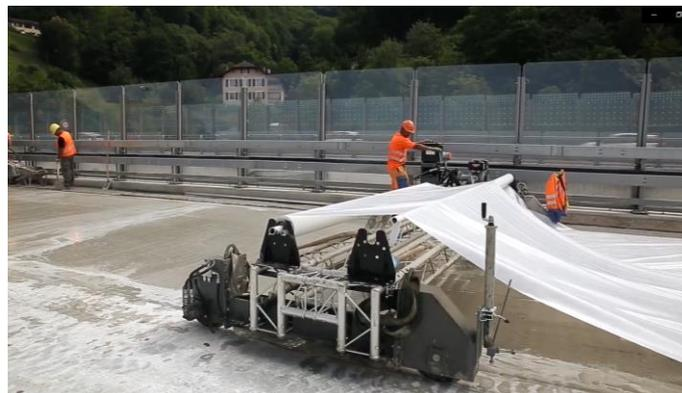
*Ilustración 56. Lonas de plástico para el curado y protección del material [24].*
