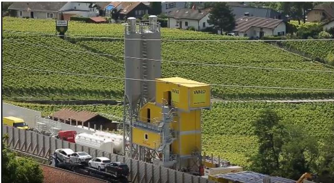
Ilustración 48. Planta en sitio de UHPFRC en el viaducto de Chillon [24].
