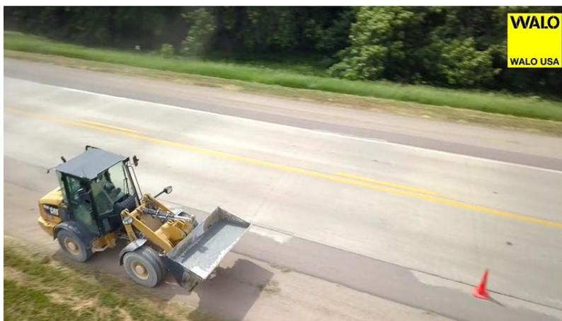
*Ilustración 63. Transporte del material a la repavimentadora [24].*
