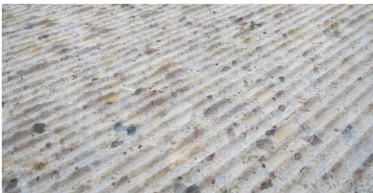
*Ilustración 37. Superficie escarificada en el tablero del puente [12].*
