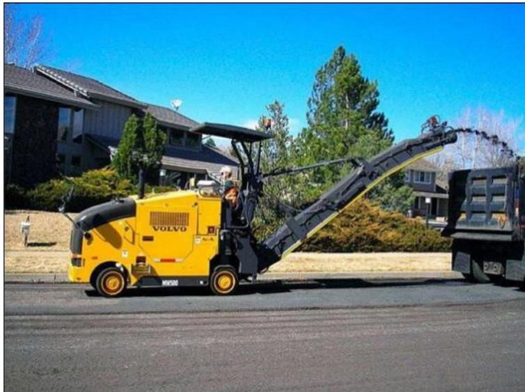
*Ilustración 30. Fresadora de pavimentos. [16]*
