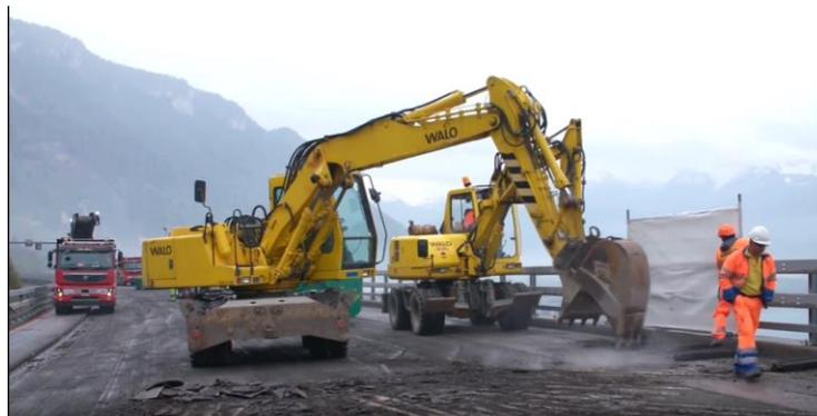
*Ilustración 50. Retroexcavadoras sobre neumáticos en el viaducto de Chillon [24].*
