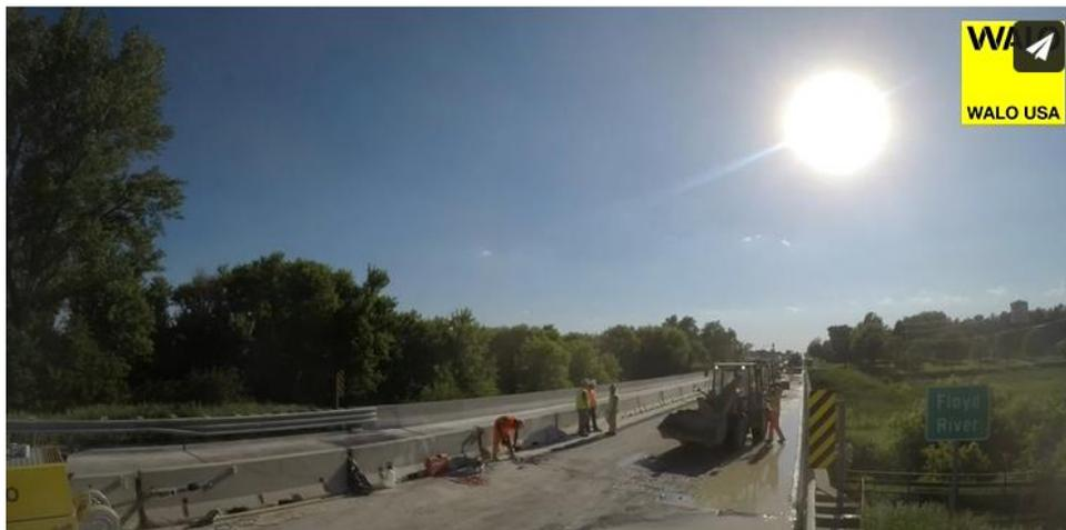
Ilustración 60. Extracción de los residuos con una retroexcavadora cargadora sobre neumáticos [24].
