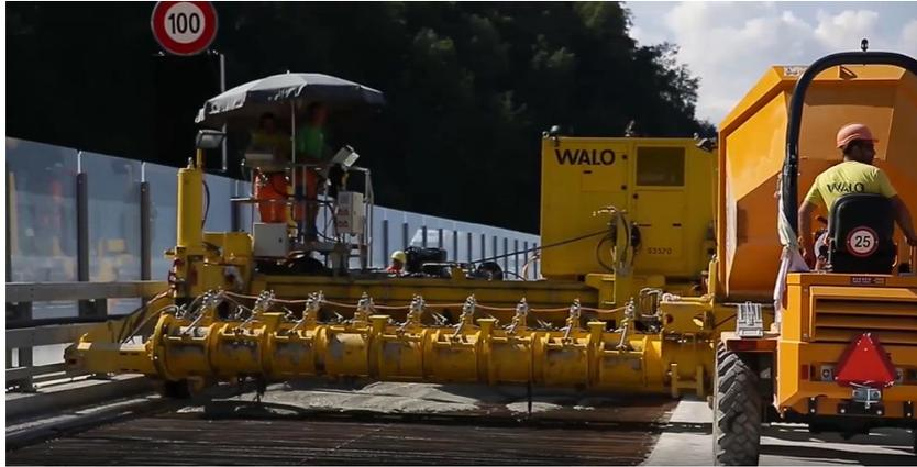
*Ilustración 54. Vaciado de UHPFRC con la repavimentadora [24].*
