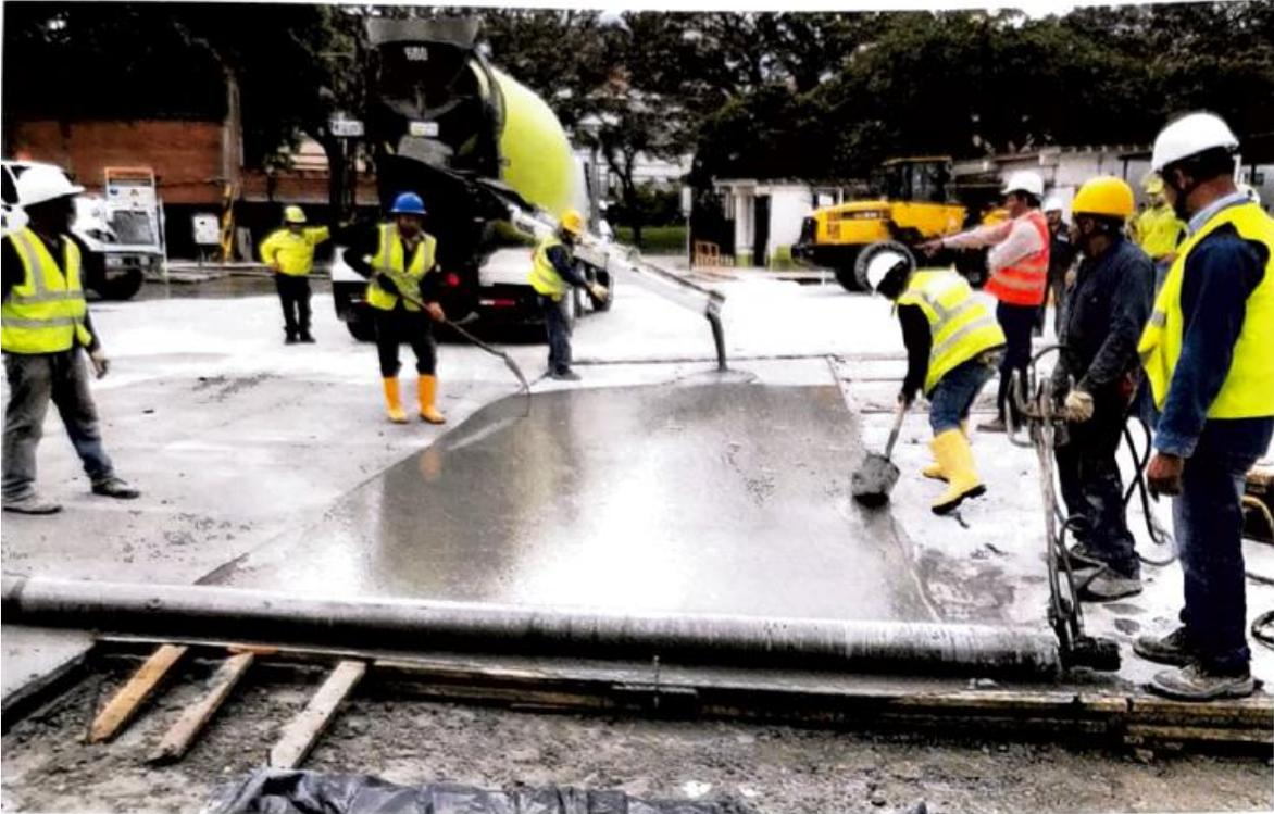
*Ilustración 25. Proceso de aplicación de sobre-carpetas de UHPC en planta de producción de concreto de Argos.[1]*
