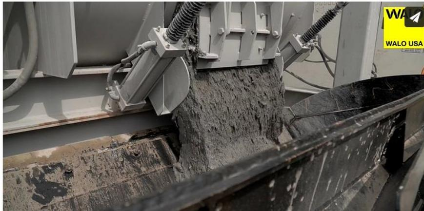
*Ilustración 62. Descarga del UHPFRC a la retroexcavadora cargadora para transportar a la repavimentadora [24].*
