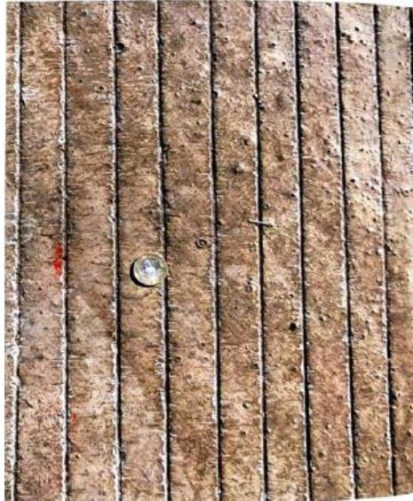
Ilustración 27. Textura de la superficie de rodadura del tramo de prueba [1].
