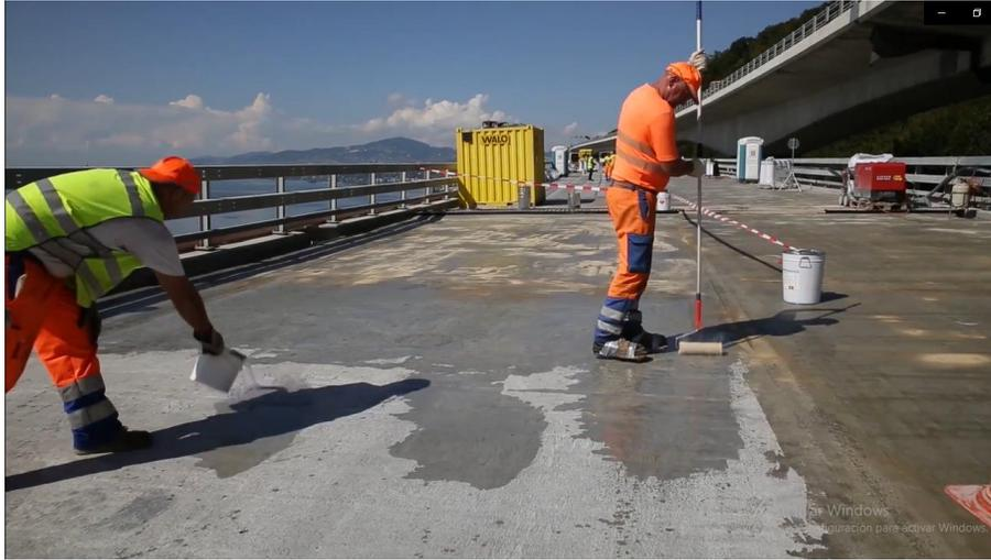
*Ilustración 57. Curado de la sobre-carpeta de UHPFRC [24].*
