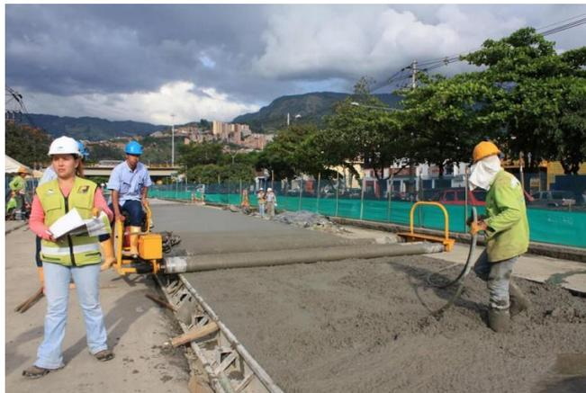
*Ilustración 26. Ejemplo de rodillo vibrante para la compactación y colocación de la sobre-carpeta.[15]*
