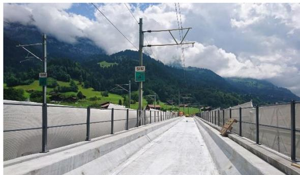
Ilustración 58. Viaducto con sobre-carpeta de UHPFRC de Kander [24].
