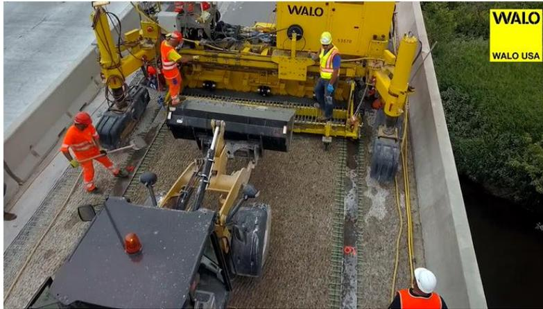
*Ilustración 64. Descarga del UHPFRC a la repavimentadora [24].*
