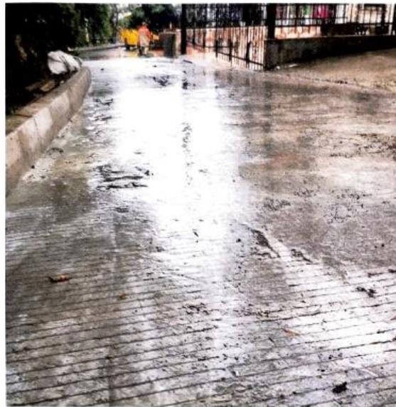
Ilustración 34. Tramo de sobre-carpeta en UHPC para uso público [1].
