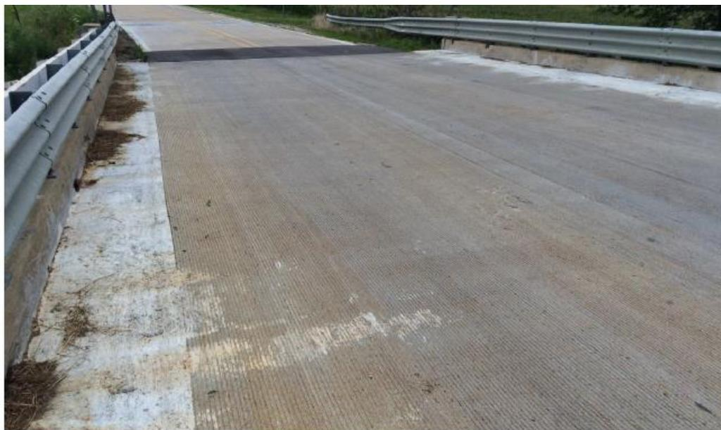
*Ilustración 40. Acabado superficial del tablero del puente [12].*
