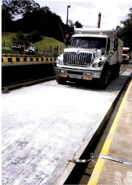
*Ilustración 29. Sobre-carpetas de UHPC en tramos de pesaje de prefabricados en Antioquia. [1]*
