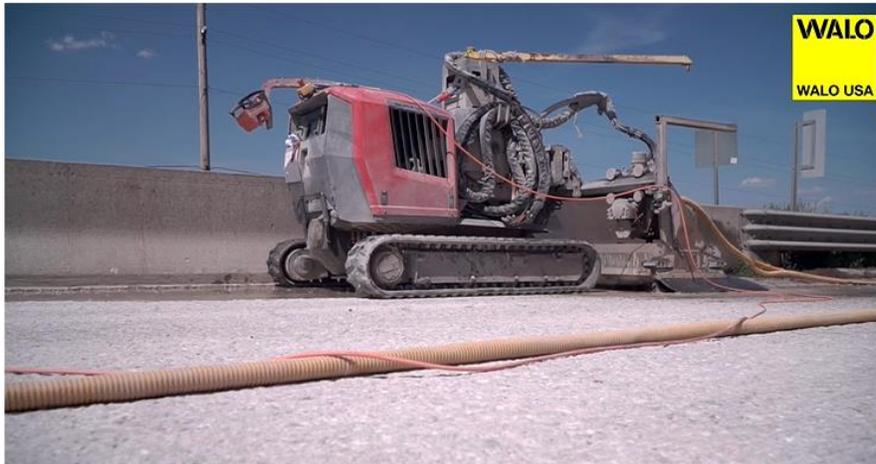
Ilustración 59. Máquina que efectúa la hidrodemolición por WALO en el puente de Sheldon, Iowa [24].
