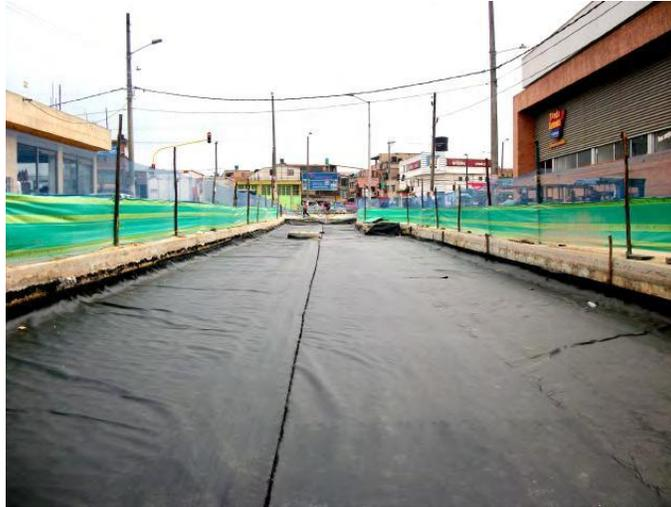
Ilustración 31. Lonas de plástico para el curado del concreto [22].
