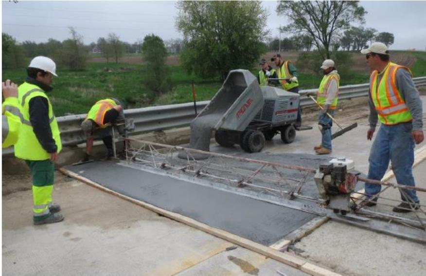
*Ilustración 38. Equipos utilizados para la colocación de la sobre-carpeta de UHPC [12].*
