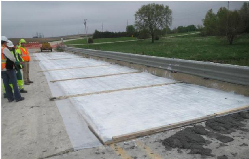
*Ilustración 39. Plástico protector del proceso de curado [12].*
