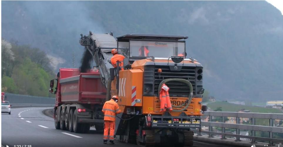
*Ilustración 49. Fresado de la capa de rodadura existente en el viaducto de Chillon [24].*
