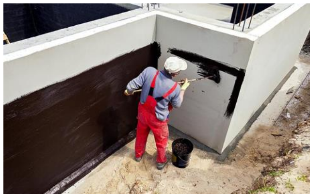
Ilustración 23. Impermeabilización de Muros. Tomado de https://www.plomerosmedellin.com
