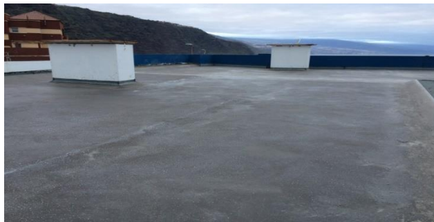
Ilustración 17. Cubierta terminada en pavimento. Tomado de https://cri.sika.com
