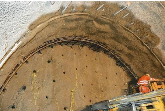
Imagen 107. Perforación y voladura-Túnel Base Brenner entre Australia e Italia, 2025.
