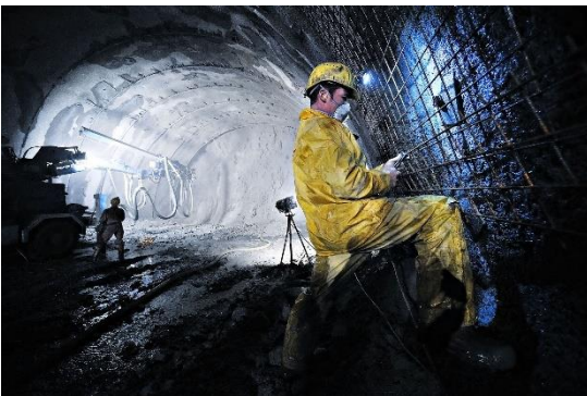
Imagen 93. Instalación de mallas-Túnel Base Brenner entre Australia e Italia, 2025.
