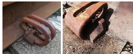
Imagen 12. Fijación rieles a) Estación Barrancabermeja b) Puente Sogamoso.
