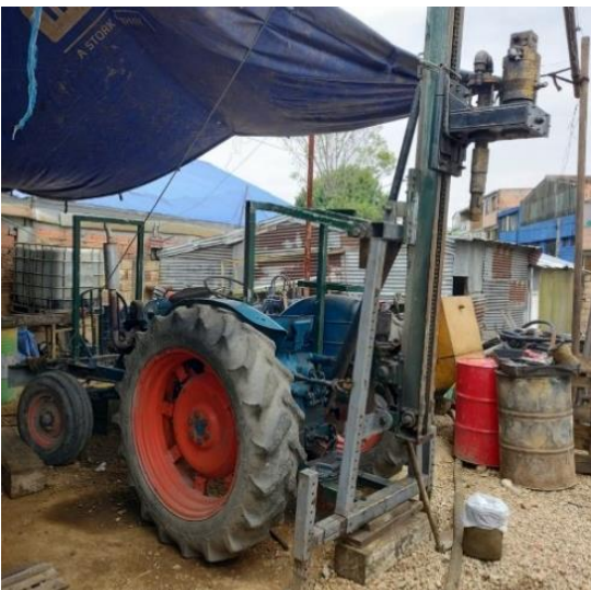
Imagen 53. Adaptación de máquina de perforación sobre el cuerpo de un tractor. Bogotá, Colombia.
