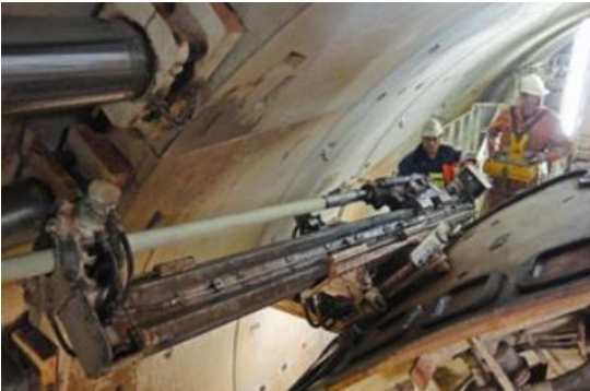
Imagen 90. Inserción de perno en fibra de vidrio.
