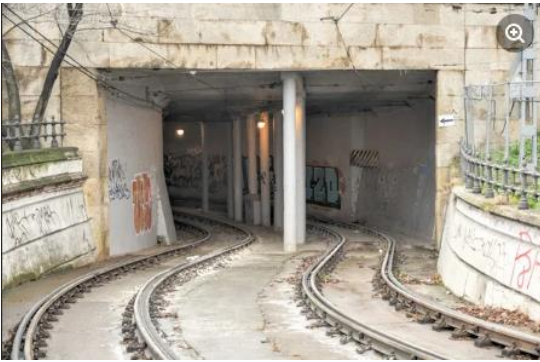
Imagen 20. Túnel de tranvía en Budapest, Hungría. Fuente: https://tinyurl.com/3zjfz7w9 .
