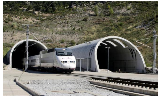
Imagen 28. Ventanas en emboquilles. Túnel del Pertús, en los Pirineos.
