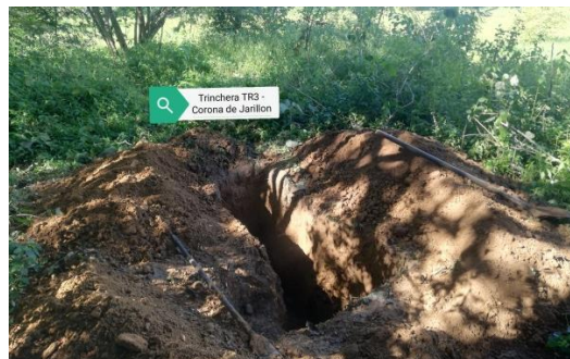
Imagen 63. Ejemplo de una trinchera en horizontal. Puerto Wilches, Santander.
