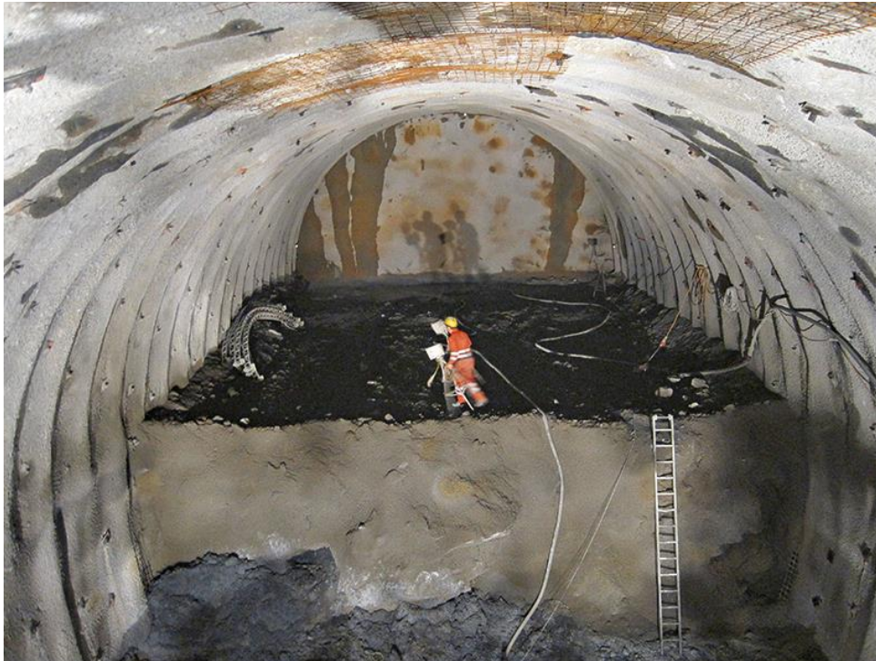
Imagen 100. Ejemplo de excavación de túneles-Túnel Base Brenner entre Australia e Italia, 2025.
