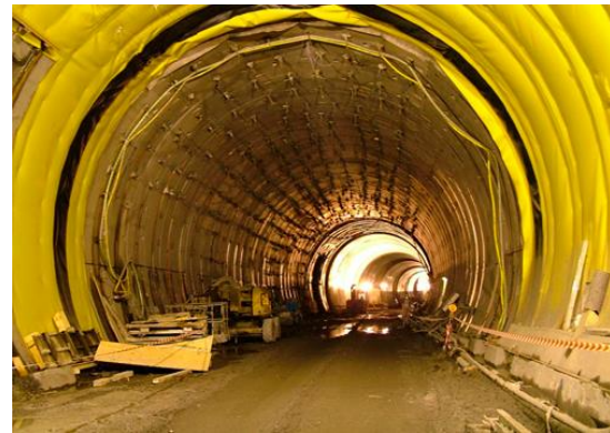
Imagen 111. Sistema de impermeabilización con geosintéticos.
