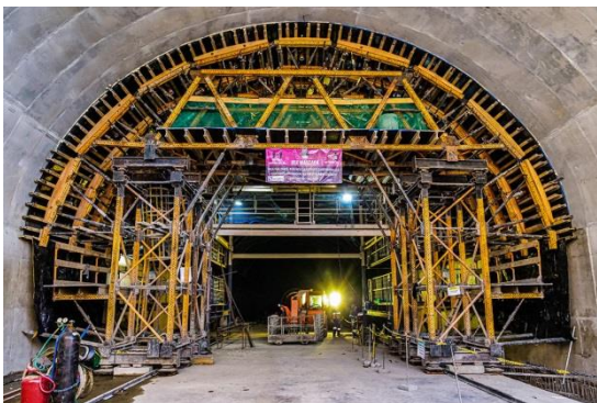
Imagen 110. Carro de encofrado utilizado para túneles Brasil.
