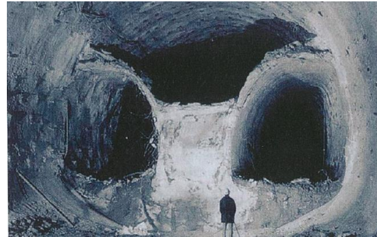
Imagen 101. Excavación sugerida por el NATM en terreno con squeezing o terrenos sueltos.
