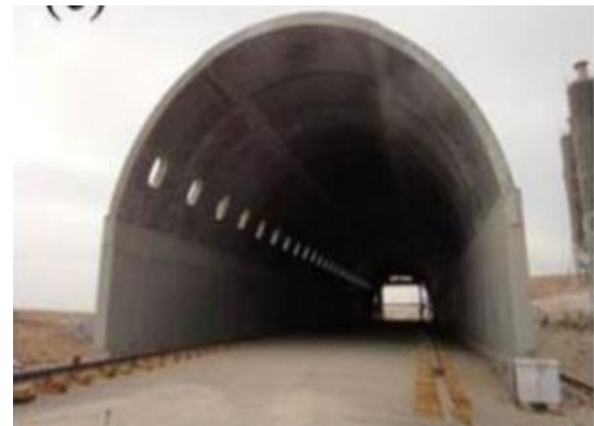
Imagen 29. Túnel de protección contra el viento.
