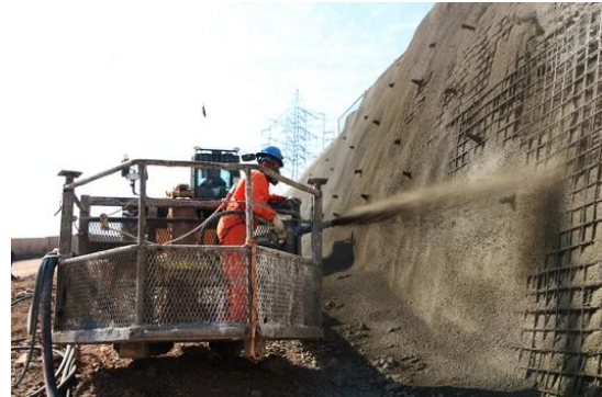
Imagen 96. Concreto lanzado.
