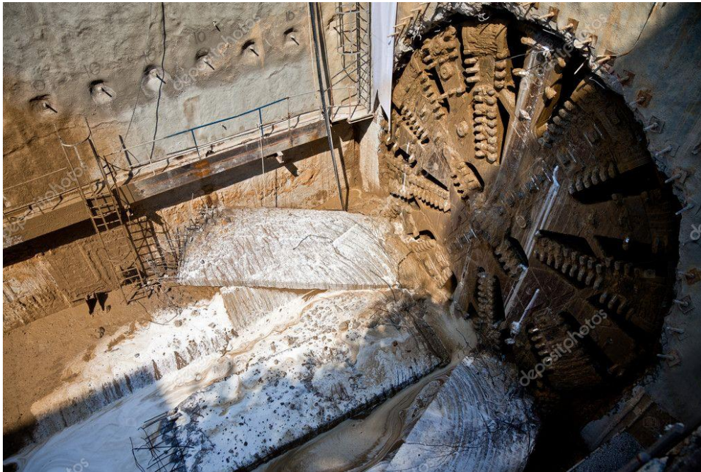
Imagen 105. TBM. Fuente: https://tinyurl.com/3rv5wtvj
