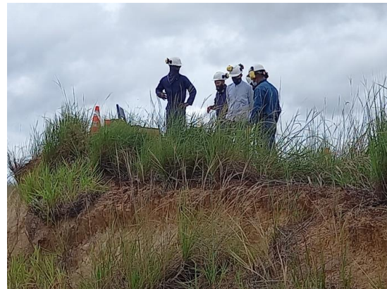
Imagen 64. Supervisión de la extracción de un bloque de arcilla con fisuras. Meta, Colombia.
