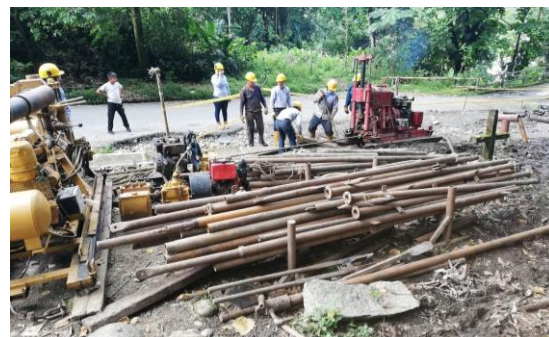
Imagen 51. Tubería de perforación. Putumayo, Colombia.
