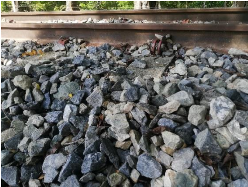
Imagen 17. Balasto vía férrea Puente Sogamoso.
