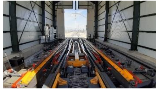
Imagen 15. Sistema de cambio de ancho de trocha.
