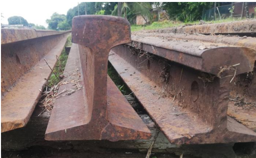
Imagen 11. Sección transversal riel en desuso. Estación Barrancabermeja.
