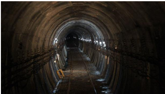
Imagen 22. Túnel en herradura tipo HPC.
