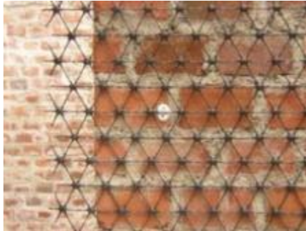
Ilustración 9. Mampostería reforzada externamente (Tiusaba, 2019 )
