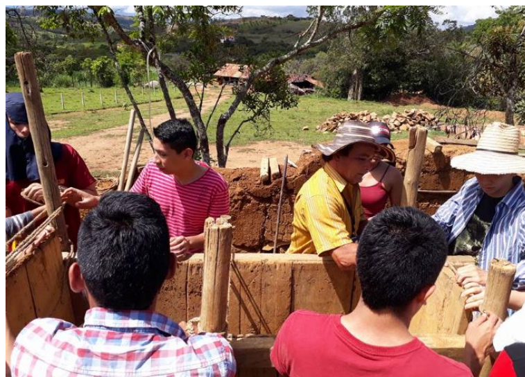
Ilustración 23. Armado de formaleta (Patiamarillos, 2019)
