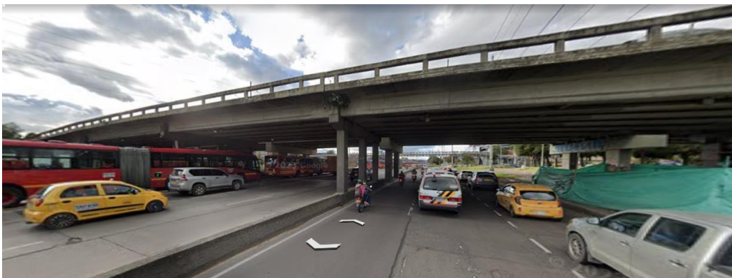
Ilustración 14 Puente viga – tablero Intersección Calle 134 con autopista norte – Bogotá D.C.
