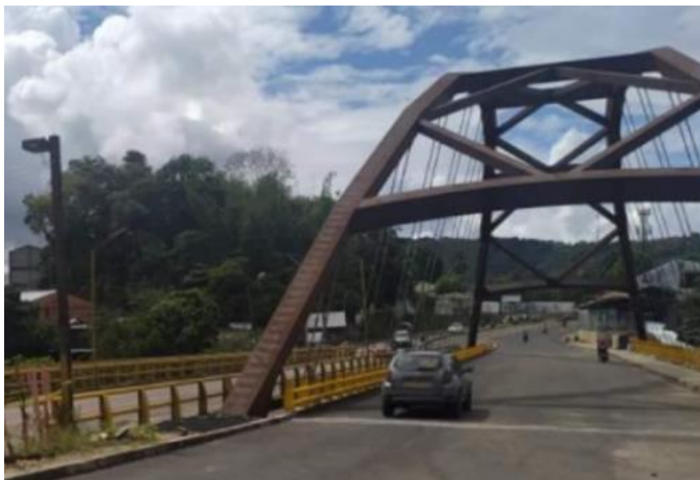
Ilustración 17 Puente en arco metálico con tablero suspendido La Perdiz – Florencia – Caquetá.
