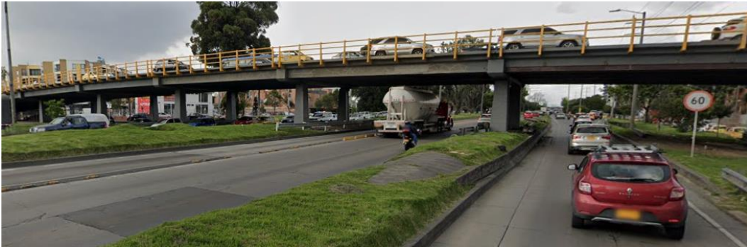
Ilustración 15 Puente viga – tablero Intersección Calle 116 con autopista norte – Bogotá D.C.
