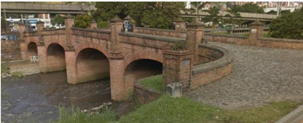
Ilustración 16 Puente en arco Puente Guayaquil sobre el río Medellín – Medellín – Antioquia.
