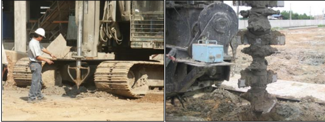
Figura 3. Proceso constructivo Soil Mixing Fuente: Horbulsk et al. (2011)
