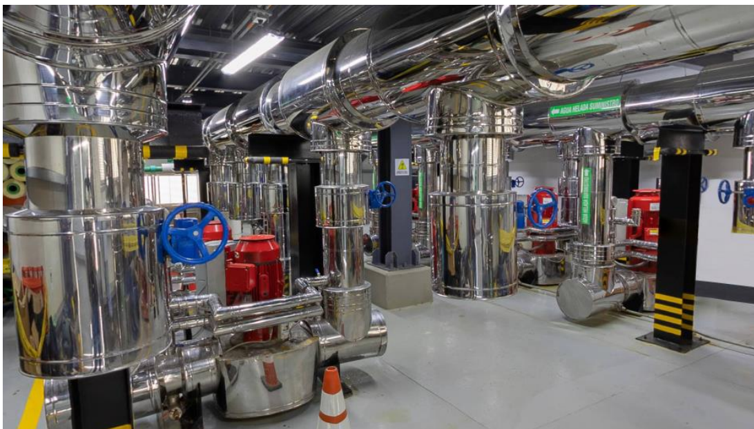
Ilustración 21 Sistema de Bombeo - Distrito Térmico de Serena De Mar, Cartagena-Colombia. Fuente: EPM
