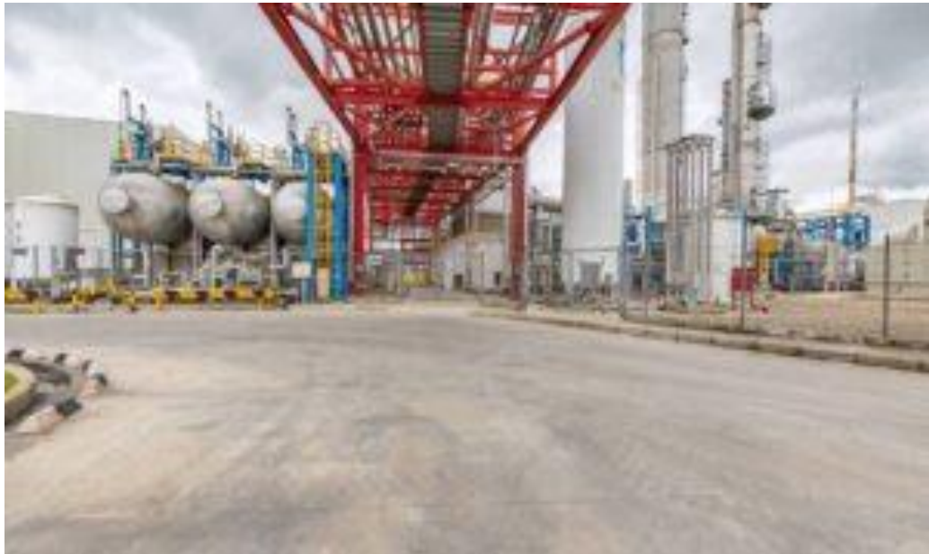
Ilustración 20 Puente de suministro - Distrito Térmico Air Liquide- Tocancipá, Colombia Fuente: Distritos térmicos en las ciudades – Recorrido virtual
