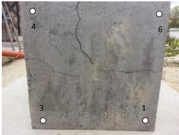
Figura 5.9. Fisuras en la zapata 1
