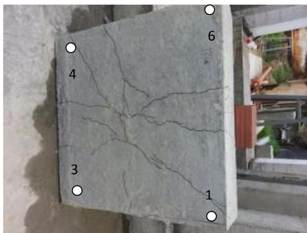
Figura 5.10. Fisuras en la zapata 2
