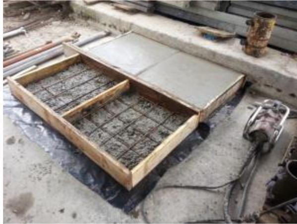
Figura 4.3. Refuerzo instalado en zapatas 2, y 3
