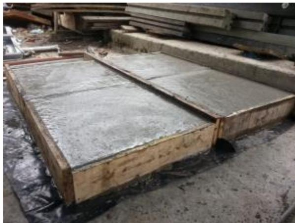
Figura 4.4. Zapatas 2 y 3 fundidas
