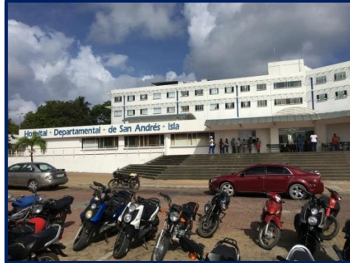
Fotografía 2. Ingreso al Hospital
