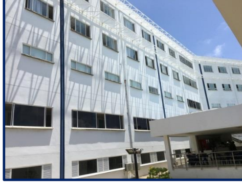
Fotografía 67. Áreas Comunes: Fachada Hospital
