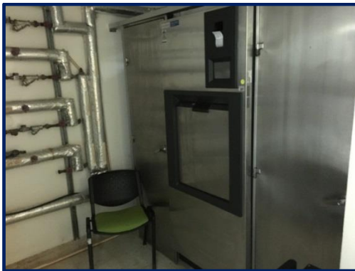
Fotografía 38. Bloque Asistencial Segundo Piso Central de Materiales
