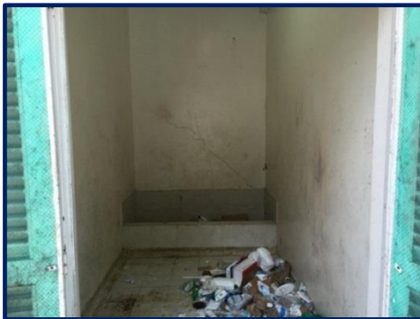
Fotografía 69. Áreas Comunes: Cuarto de Almacenamiento Central de Residuos
