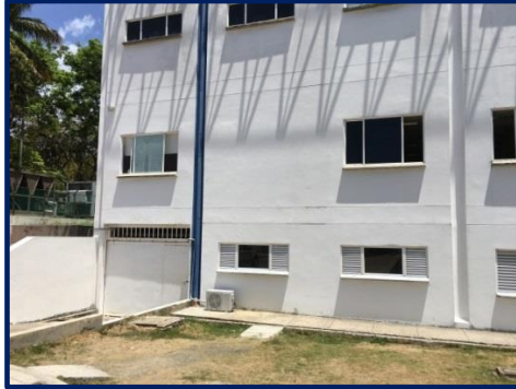
Fotografía 66. Áreas Comunes: Fachada Hospital
