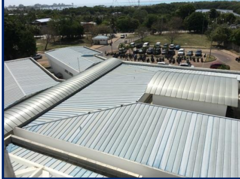
Fotografía 59 Vista Superior Parqueadero Hospital
