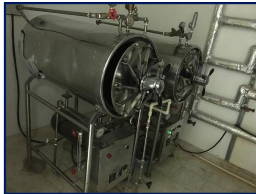
Fotografía 39 Bloque Asistencial Segundo Piso Central de Materiales
