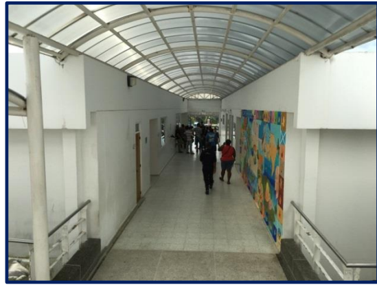
Fotografía 8. Pasillo de entrada principal
