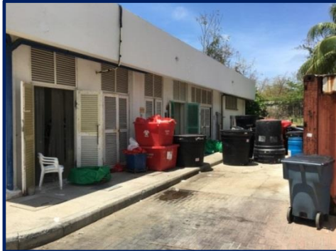
Fotografía 70. Áreas Comunes: Cuarto de Almacenamiento Central de Residuos
