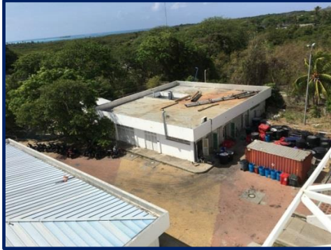
Fotografía 58. Áreas Comunes: Cuarto de residuos , calderas
