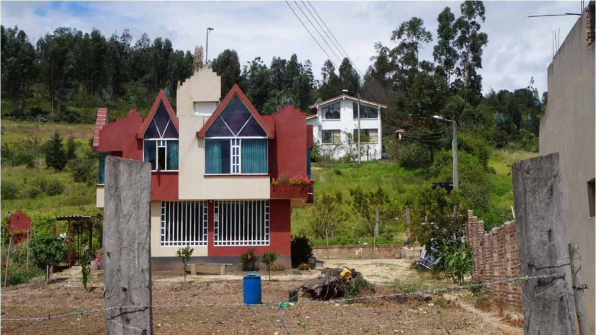
Foto 5: Características de algunas construcciones del sector.
