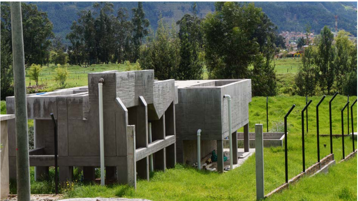
Foto 6: Planta de tratamiento de aguas residuales (PTAR) de la vereda El Chorrito.
