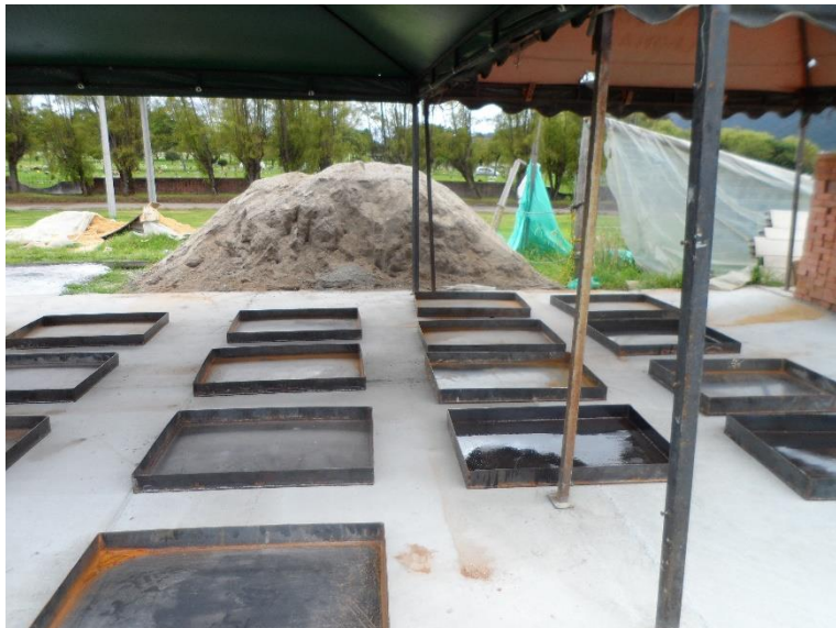
Fotografía 3.2 Disposición de las formaletas.
