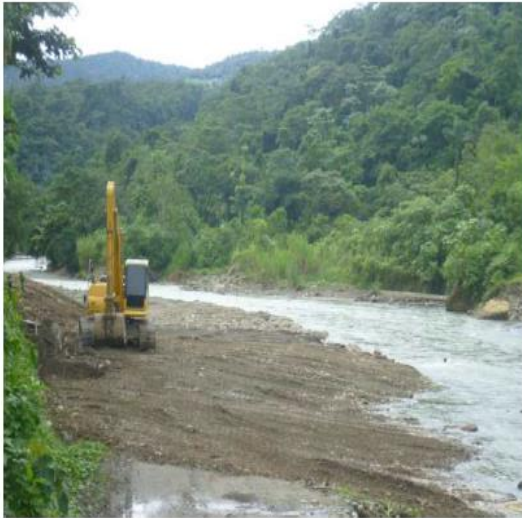
Figura 2. Intervención minera con maquinaria.
