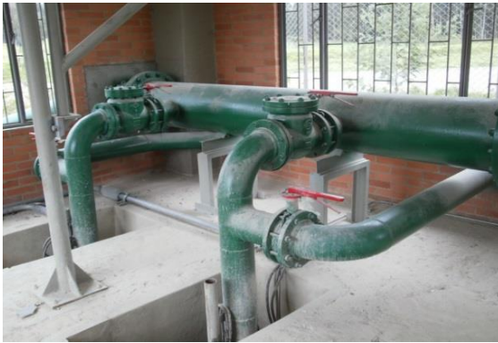
Fotografía 2. Sistema de bombeo PTAP Los Patos
