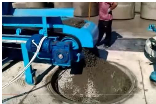
Figura 28 Llenado de prensa vibrocompactadora Fuente. https://www.youtube.com/watch?v=3b2e4FizRUg
