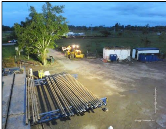
Construcción de la plataforma
