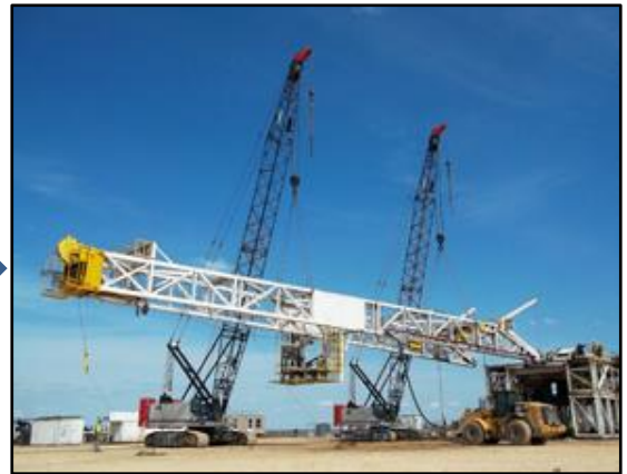
Movilización del taladro y otros equipos
