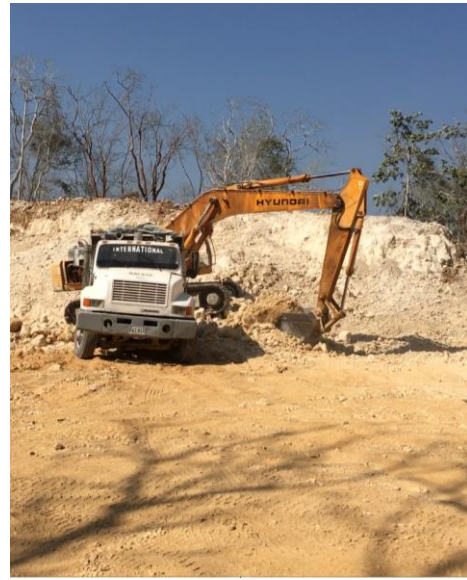
Cargue del material extraído
