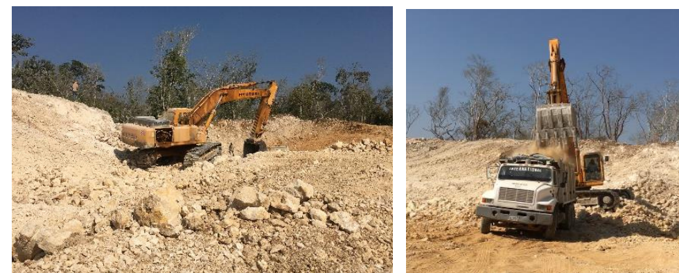
Cargue del material extraído
