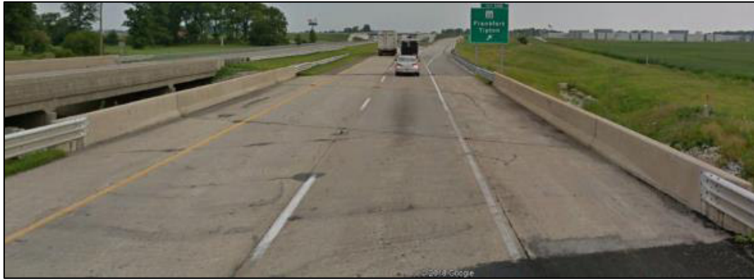
Fotografía 1 Estado actual del puente No 1.
