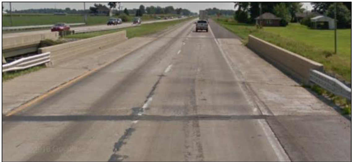
Fotografía 2 Estado actual del puente No 2
