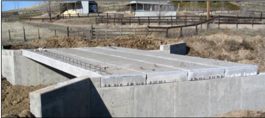
Figura 1 Puente tipo losa en concreto reforzado
