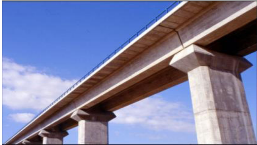
Figura 2 Puente tipo viga - losa en concreto reforzado
