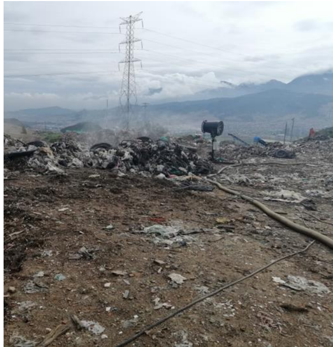
Figura 16 Cañones de aspersion en el patio de operaciones.
