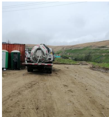
Figura 13 Limpieza de baños portátiles
