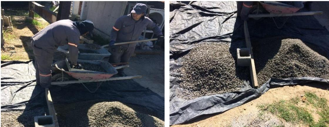
*Ilustración 3-12 Combinación y separación de agregado común*
