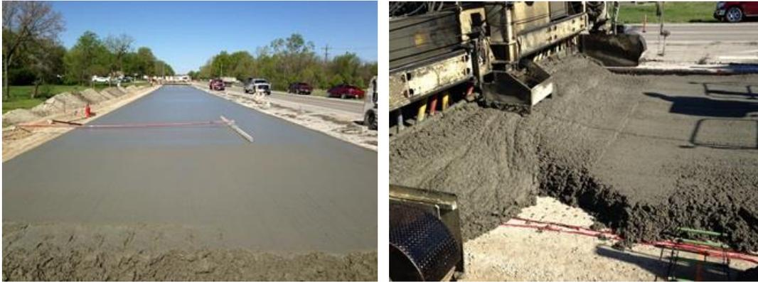
*Ilustración 1-8 Aplicación de concreto IC en autopista US 54*
