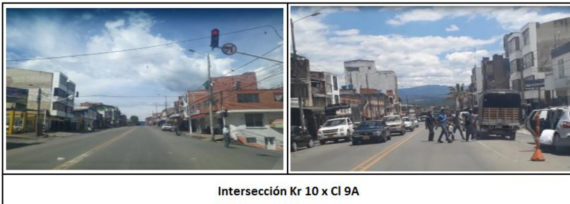
Figura 7-9. Señalización Intersección Kr 10 X CI 9A
