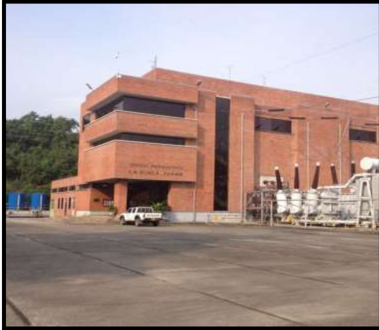
Foto 7 - CENTRAL HIDROELECTRICA LA GUACA
