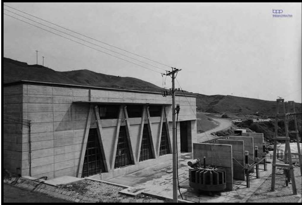
Foto 10 - CENTRAL HIDROELÉCTRICA TRONERAS
