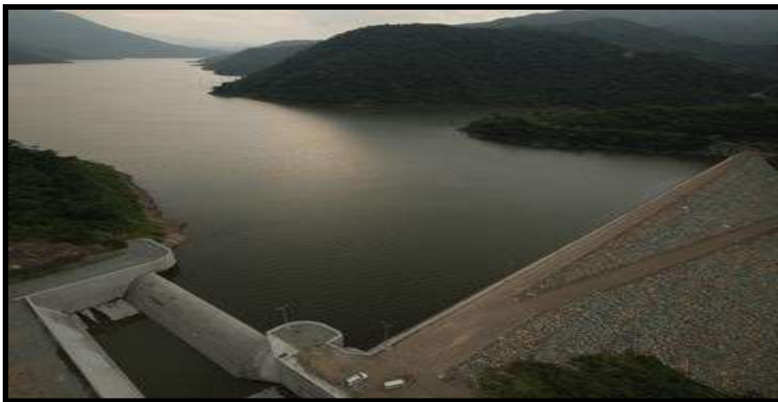
Foto 38 - ESTRUCTURA DE CONTENCIÓN - EMBALSE DEL RIO RANCHERÍA
