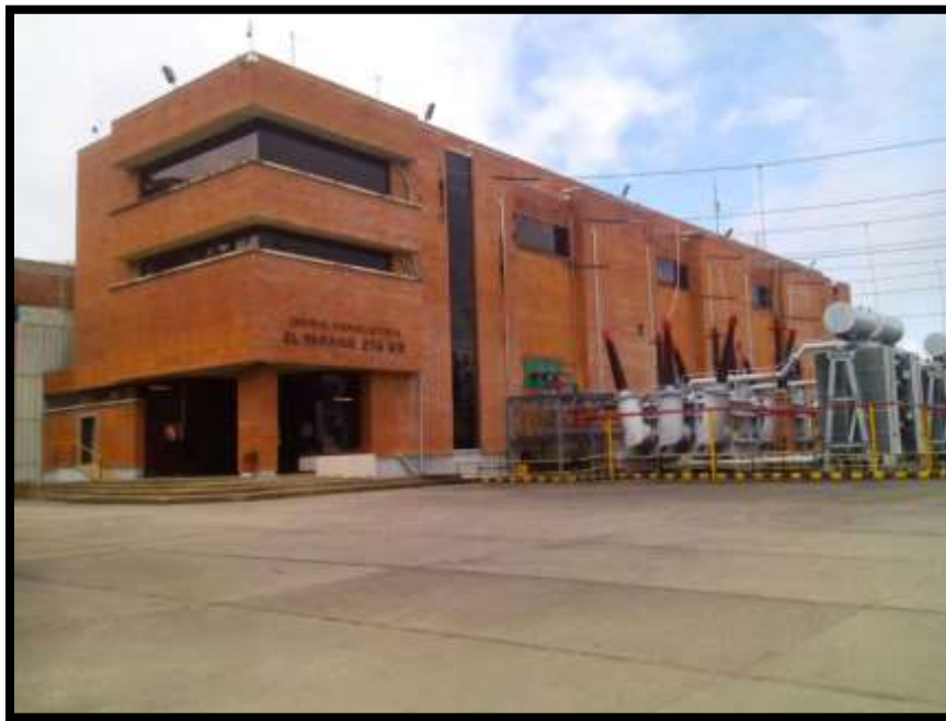
Foto 6 - CENTRAL HIDROELECTRICA PARAISO
