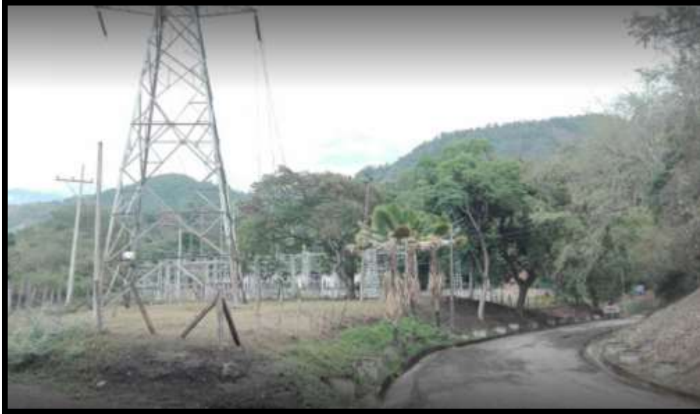
Foto 20 - CENTRAL HIDROELECTRICA DARIO VALENCIA S.
