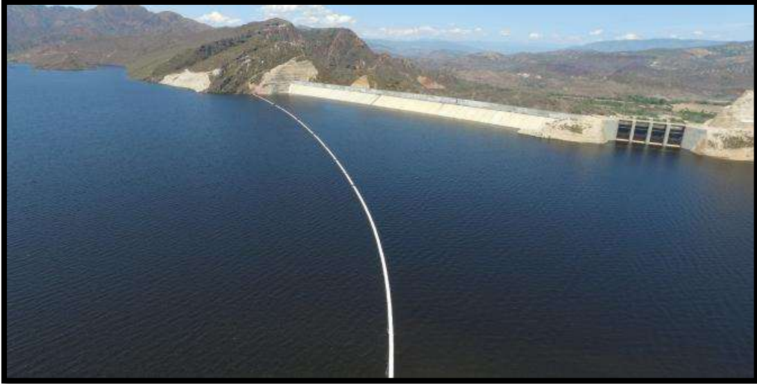
Foto 14 - HIDROELECTRICA EL QUIMBO
