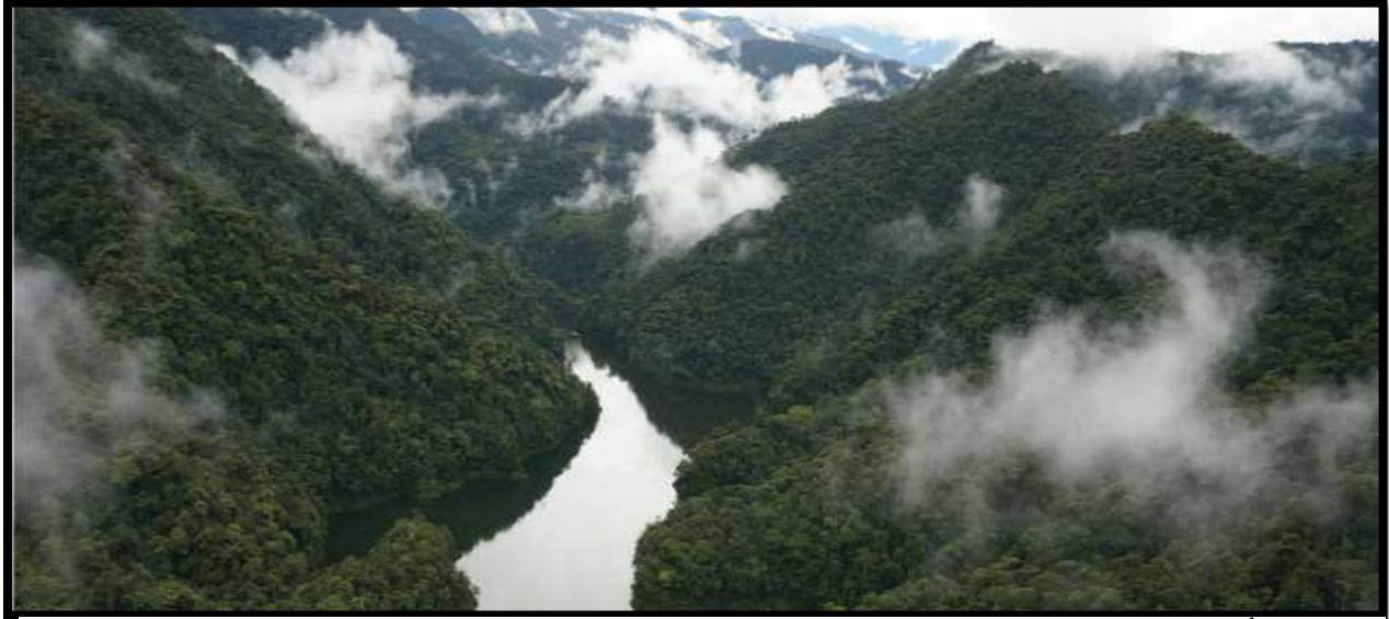
Foto 11 - CENTRAL HIDROELECTRICA ALTO Y BAJO ANCHICAYÁ
