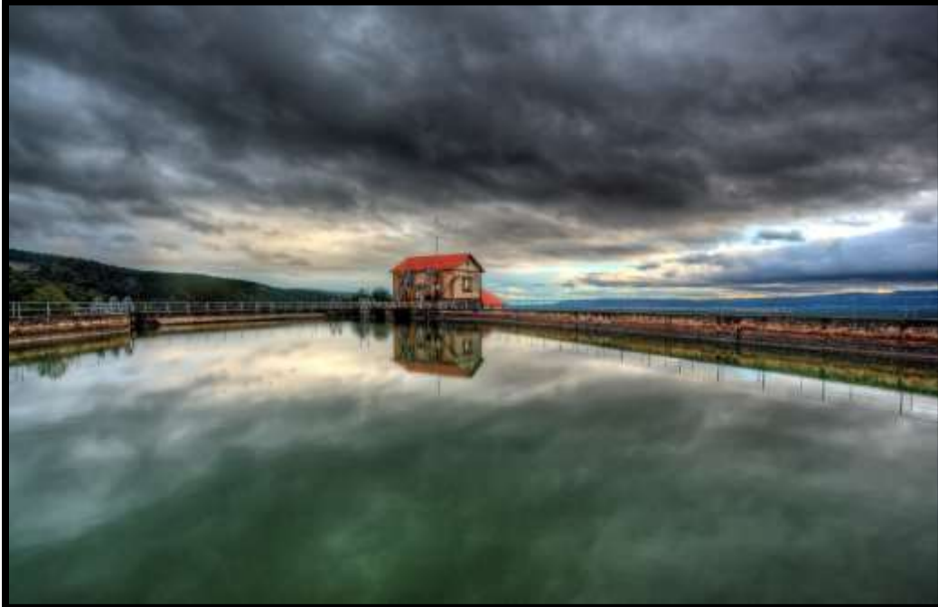
Foto 28 - PERSPECTIVA DEPOSITO DE LA CENTRAL ELECTRICA EL SALTO
