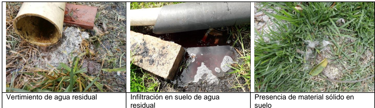
Figura 6 Descarga aguas residuales
