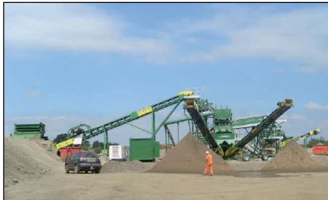
Figura 2-1: Planta de reciclaje de concreto. Noticreto Edición 108.
