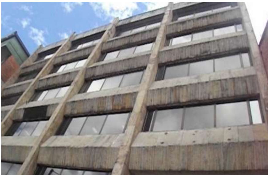
Imagen 43. Vista General Estructura 5.
