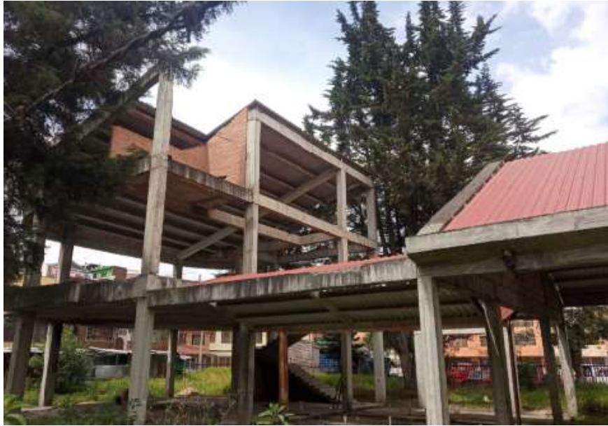
Imagen 13. Vista General Estructura 2
