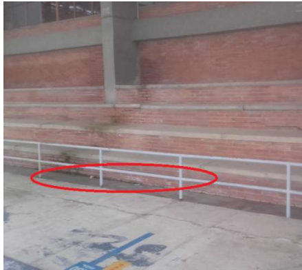
Imagen 11. Asentamientos diferenciales
