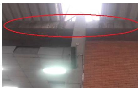
Imagen 10. Acero expuesto en vigas
