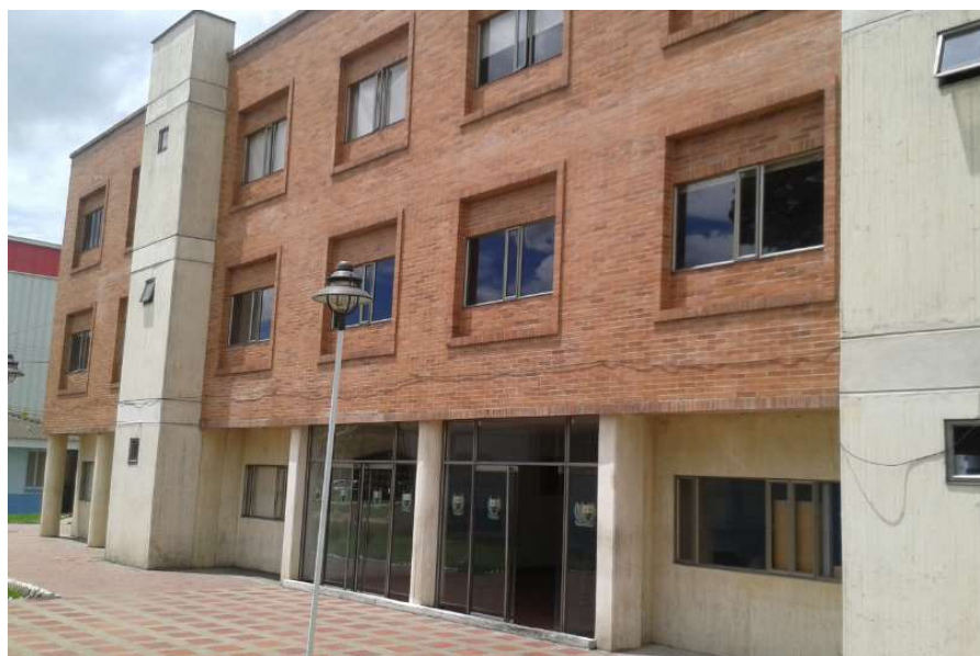
Imagen 36. Vista General Estructura 4.
