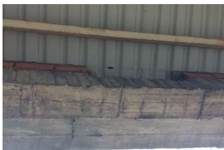
Imagen 23. Cambio de sección en viga
