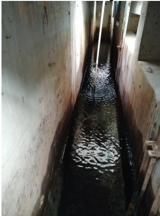
Ilustración 10 Canal de agua filtrada
