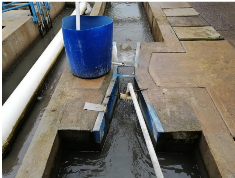
Ilustración 2 Canaleta Parshall
