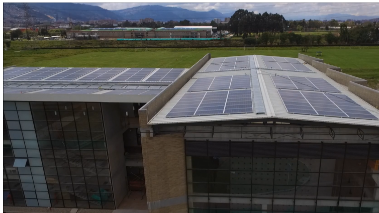
Figura 4.1: Foto de perfil de la instalación sobre superficie del edificio Alejandro Sandino. Tomado de [30]
