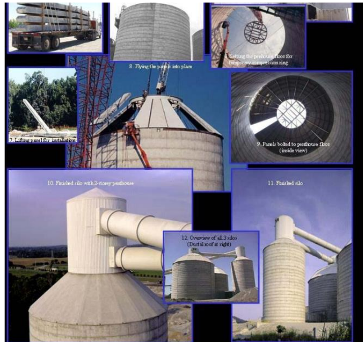
Figura 6. Joppa silo para Clinker (2001 Illinois, USA)
