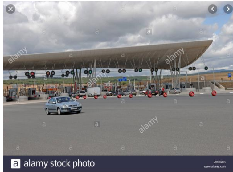
Figura 8. Cubierta Peaje Viaducto Millau
