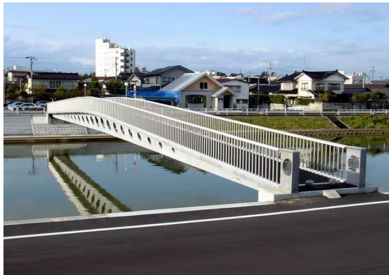
Figura 7. Pasarela Sakata Mirai
