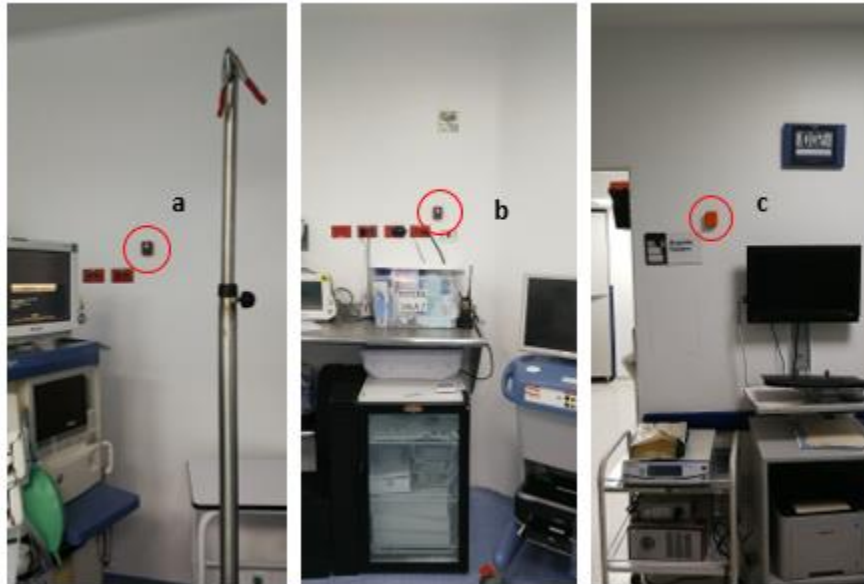
Figura 19. Dispositivos instalados: sala 2 (a), sala 7 (b) y exterior (c).
