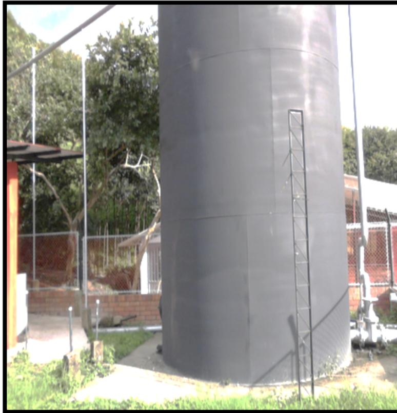
**Figura 7.** Reactor No.1 anaeróbico de flujo ascendente, RAFA. Alcaldía de Togüí, 2019.
