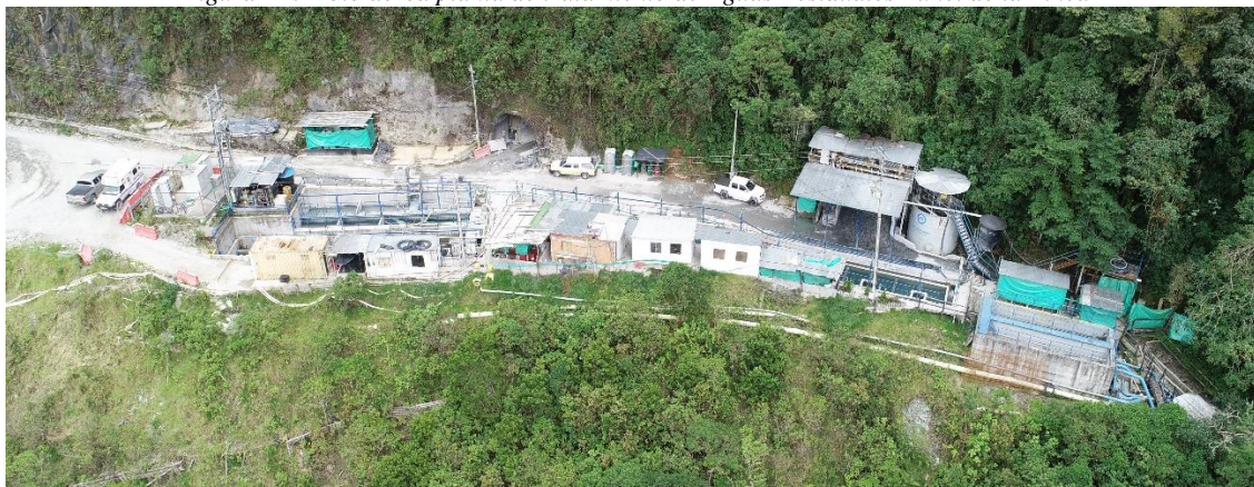
Figura 4-3 Foto aérea planta de tratamiento de Aguas Residuales Túnel de la Línea
