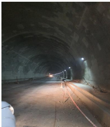
(Derecha) Estado final concreto lanzado y (Izquierda) cunetas transversales recolectoras aguas de infiltración
