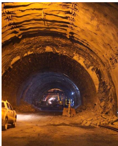
(Derecha) Excavación y obras para superar pasó de fallas (Izquierda) impermeabilización del Túnel II
