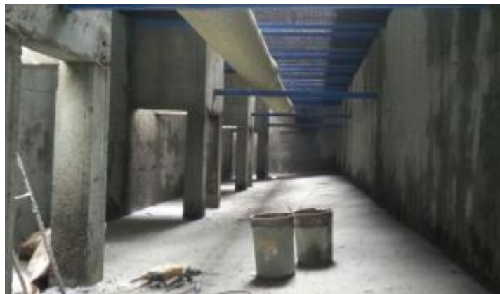
Figura 4-24 Interior de los sedimentadores en etapa de construcción, buitrones, fondo del sedimentador, tubería de distribución de agua floculada de 20".
