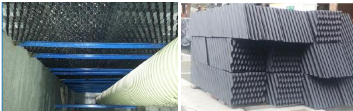
Figura 4-25 Interior de los sedimentadores en etapa de construcción, paneles de sedimentación de alta tasa, tubería de distribución de agua floculada de 20"
