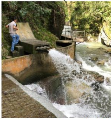
Fuente: Informe final de construcción – INVÍAS
