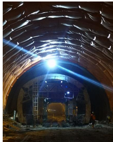
(Derecha) Excavación y obras para superar pasó de fallas (Izquierda) impermeabilización del Túnel II
