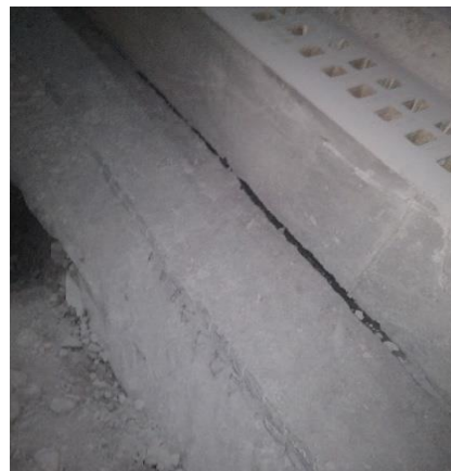
(Derecha) Estado final concreto lanzado y (Izquierda) cunetas transversales recolectoras aguas de infiltración
