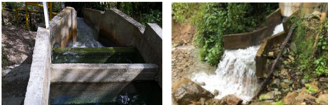
Figura 4-35 Vertimiento de la PTARC Quebrada la Gata y Vertimiento Rio Santo Domingo
