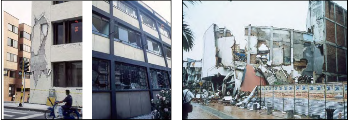
Figura 21 Sismo de Pereira, 1995
