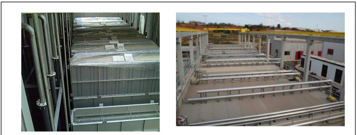
Figura 20 Módulos BRM tipo Kubota EK400
