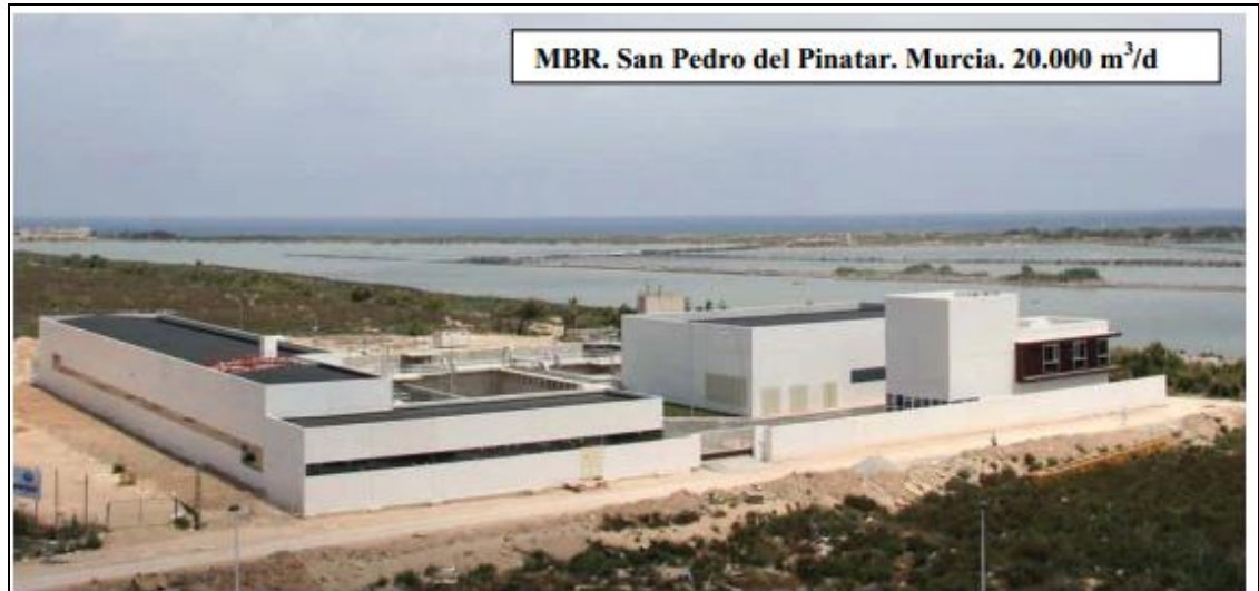
Figura 18 Vista general Planta San Pedro del Pinatar – España
