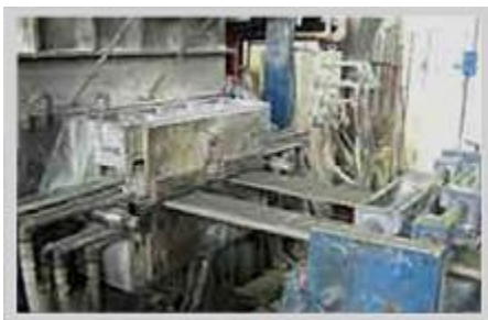
Figura No. 6 Sistema de extracción
