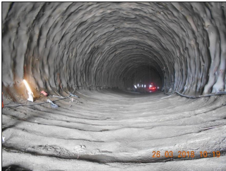
Figura 51 Túnel 1 F3 G2 (UF1). Tramo de solera entre el K62+695-K62+478.40. Fuente: Consorcio Metroandina
