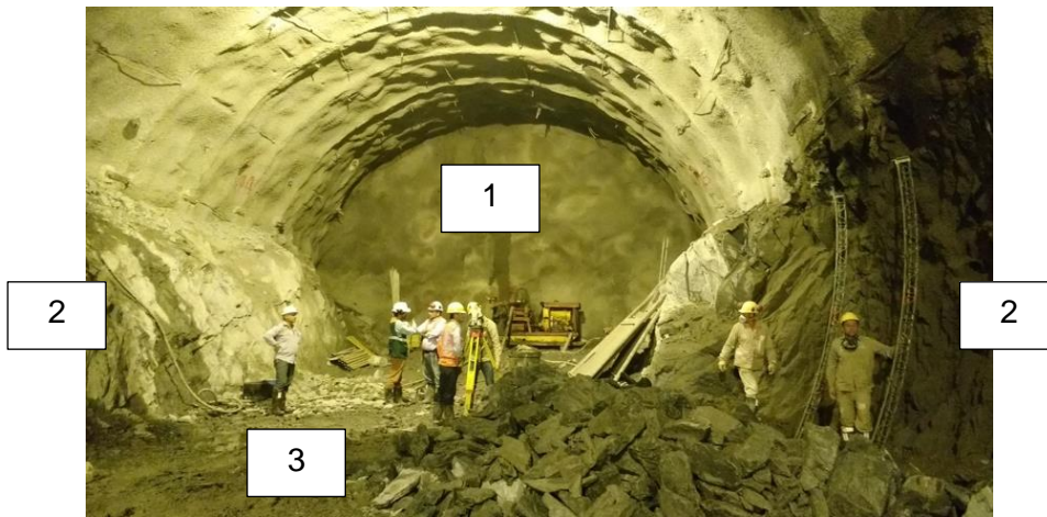
Figura 67 Excavación subterránea sección superior (1), bancas (2) y solera (3). Fuente: Consorcio Metroandina.
