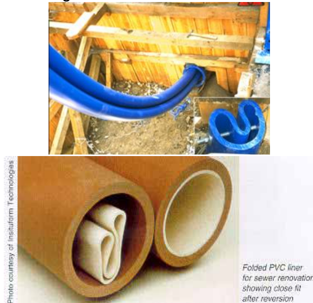
Figura 11. Tubería deformada.
