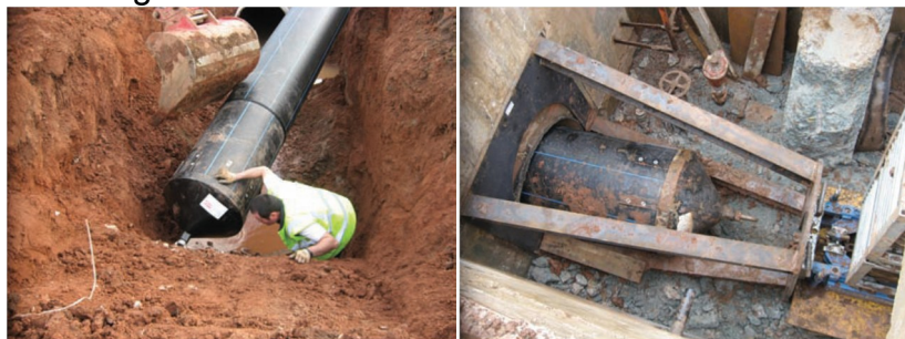
Figura 14. Revestimiento tuberías continuas.
