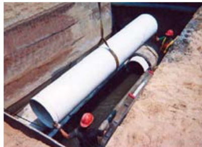
Figura 15. Revestimiento con cemento de tubo.
