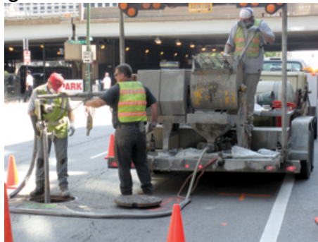
Figura 7. Estabilización con mortero
