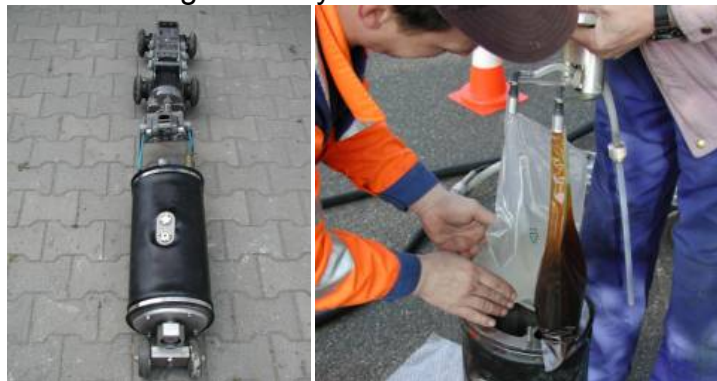
Figura 9. Inyección de resina.
