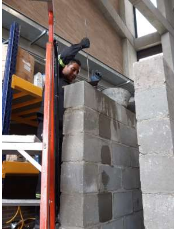
Fotografía 4-11 Vibrado para eliminar acumulación de aire en el grout
