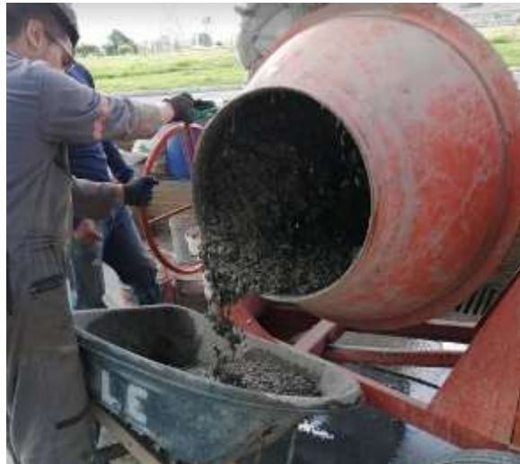
Fotografía 4-2 Elaboración del grout de relleno para muros de mampostería de concreto
