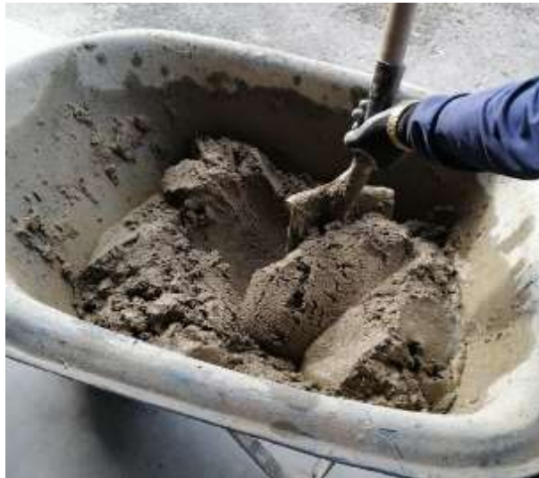
Fotografía 4-1 Elaboración del mortero de pega
