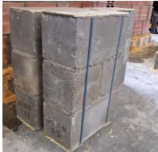
Fotografía 4-4 Elaboración de muretes de mampostería
