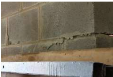
Aplastamiento en el mortero de pega
