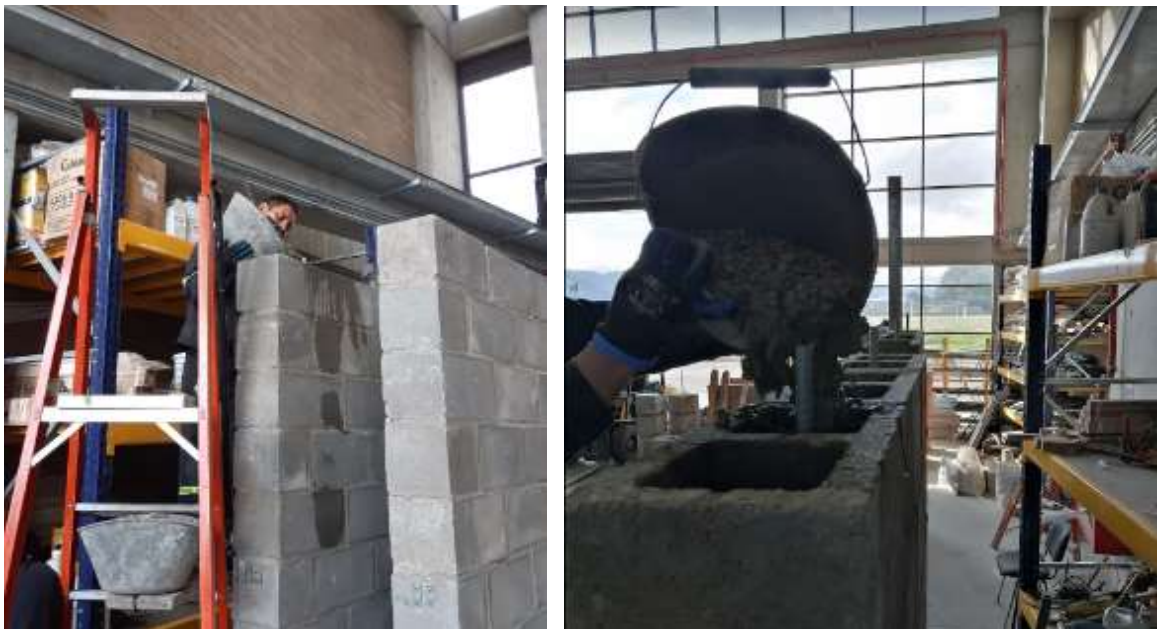
Fotografía 4-10 Instalación del grout de relleno de las celdas
