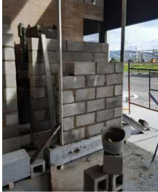
Fotografía 4-7 Elaboración de muro de mampostería de concreto
