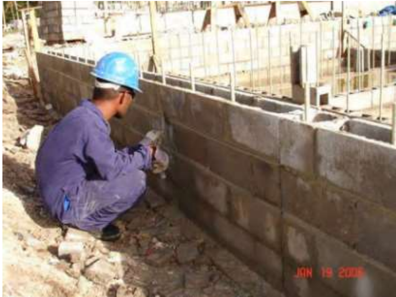
Fotografía 1-3 Uso de barras de FRP como refuerzo interno de mampostería de concreto
