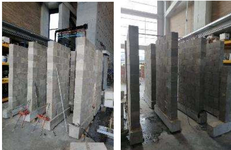
Fotografía 4-12 Almacenamiento de muros ya construidos
