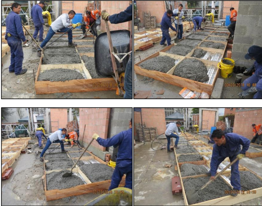
Figura 32. Vaciado y vibrado del concreto. Fuente: Elaboración propia
