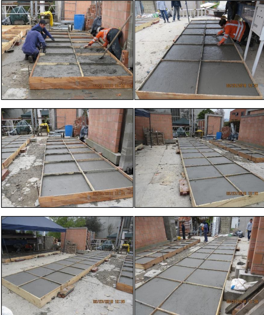
Figura 33. Afinado y curado del concreto. Fuente: elaboración propia
