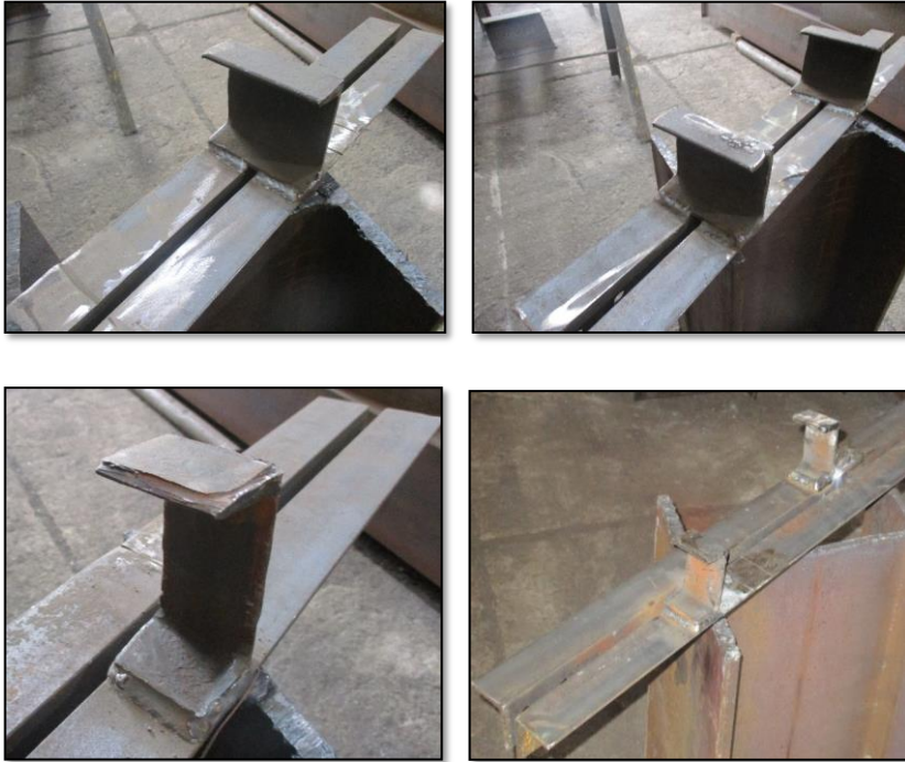
Figura 28282934 . Armado de conjuntos. Fuente: Elaboración propia.
