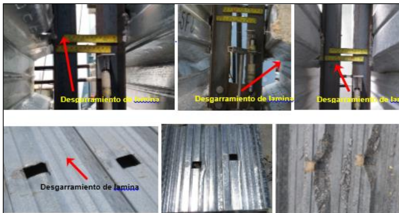
Figura 53. Abombamiento lamina colaborante Fuente: Elaboración propia
