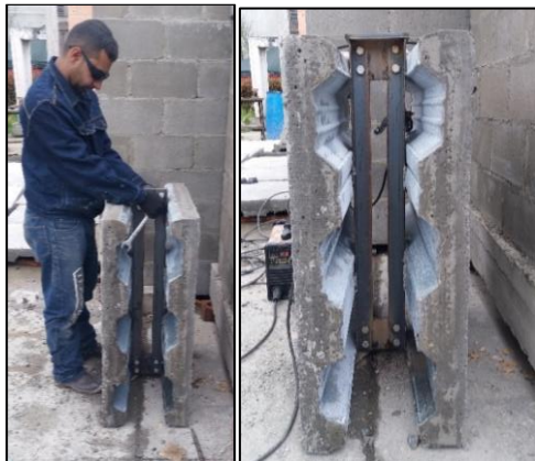
Figura 35. Localización de platinas y apriete de tornillos. Fuente: Elaboración propia
