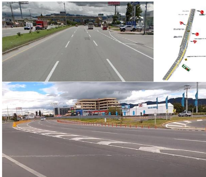
Figura 33 Obras de mejoramiento entre PR 9 y PR 10 Sector Fontanar-Devinorte
