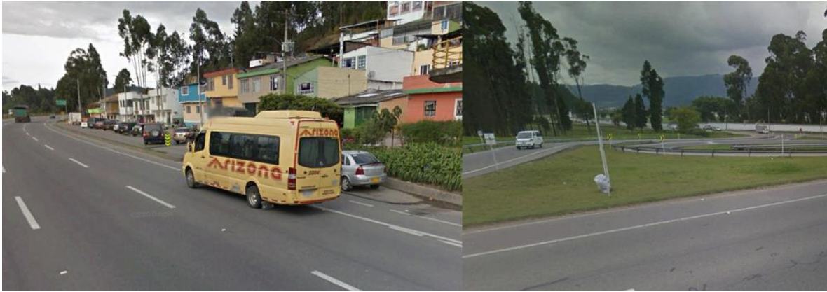
Figura 35 recomendaciones pacificación entre PR 14 y PR 15 Sector Hatogrande-Devinorte Fuente: Elaboración propia con imagen de Google Earth
