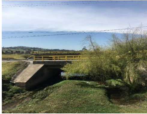
Fotografía 4. Puente, vía Bogotá - Tunja, ubicado cerca de la descarga del Río Tejar Fuente: Autora 2020
