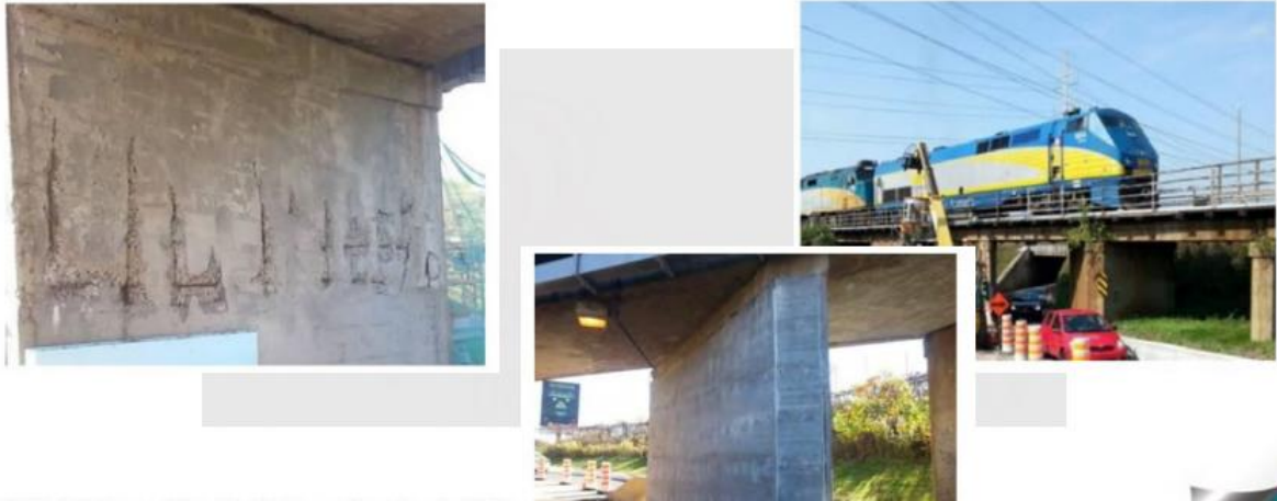
Figura 1.4 – Rehabilitación de pantallas, concreto UHPFRC
