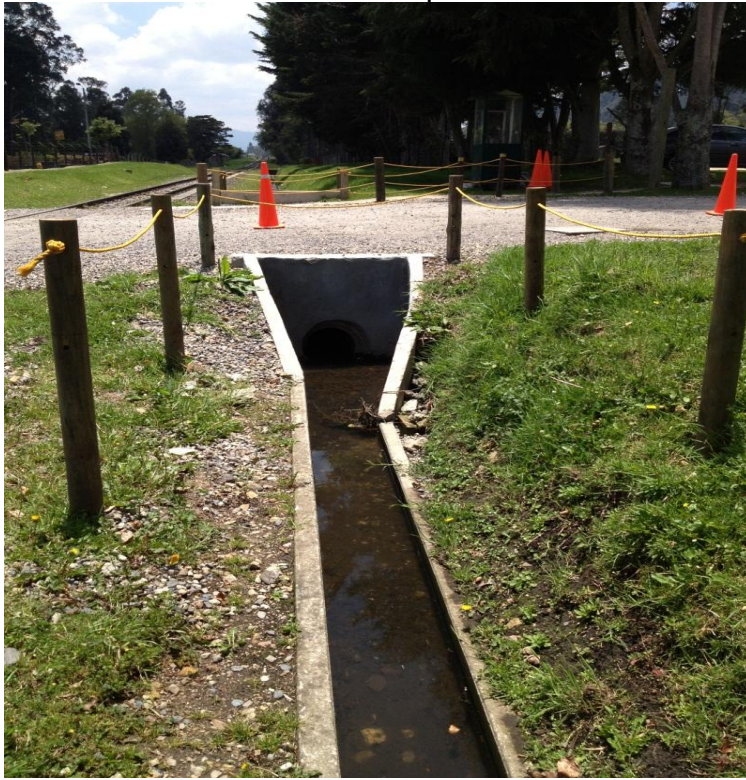
Foto 7 Cuneta en paso a nivel
