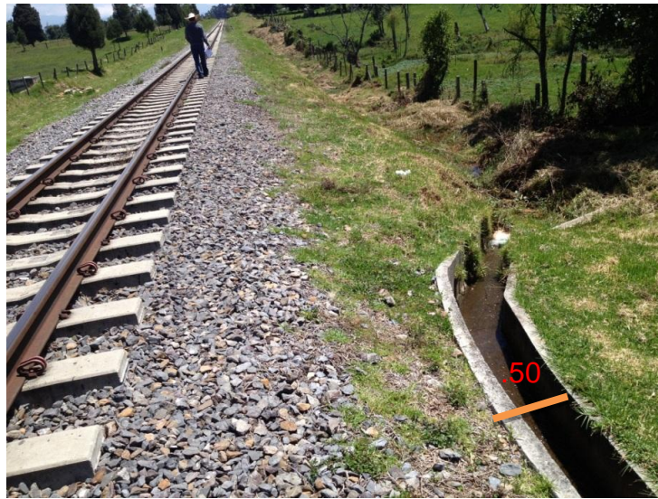
Foto 5 Cunetas Transversales a La Vía
