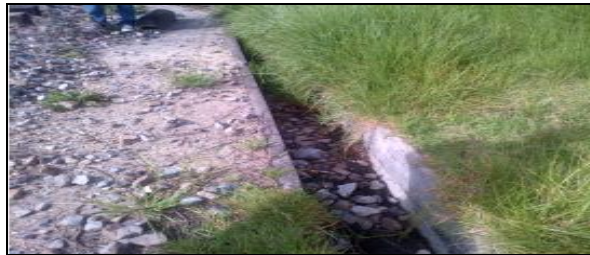
Foto 2 Cuneta en concreto
