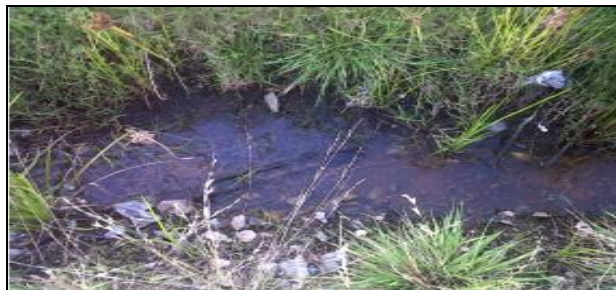
Foto 1 Cuneta en Tierra
