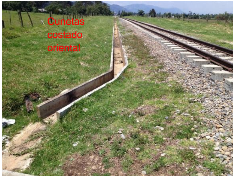
Foto 6 Cunetas Transversales a La Vía
