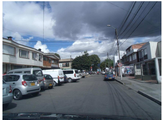
Ubicación: calle 24C entre la carrera 75 a la carrera 81
