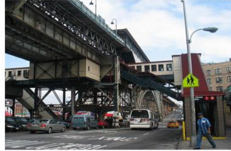
La estación de la Calle 125 en la línea 7 Av – Broadway Fuente: https://es.wikipedia.org/wiki/Metro_de_Nueva_York#/media/Archivo:Subway_elevated2.jpg
