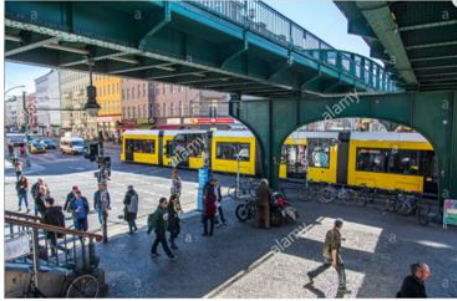
Estación de metro Eberswalder Straße en Berlín
