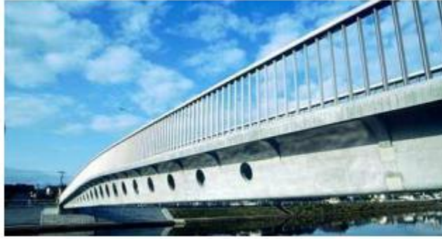
Figura 1.4 – Pasarela Sakata Mirai [11]
