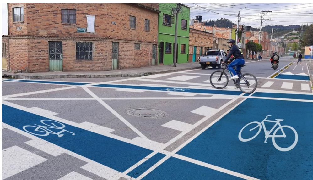
Figura 40. Intersección calle sexta con carrera once. Elaboración propia del autor
