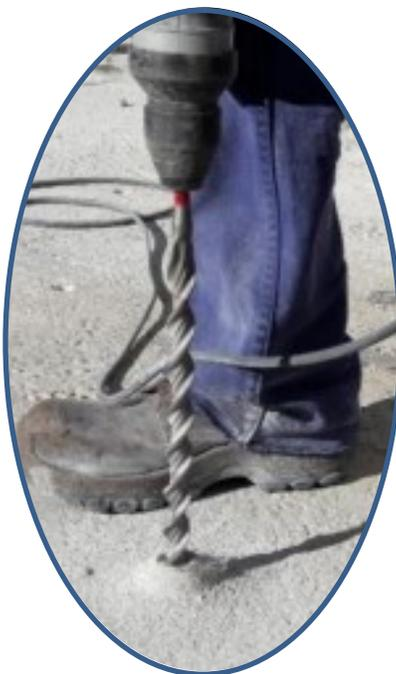
*Figura 14: Perforación de las losas con taladro rotopercutor. Fuente: Autor.*
