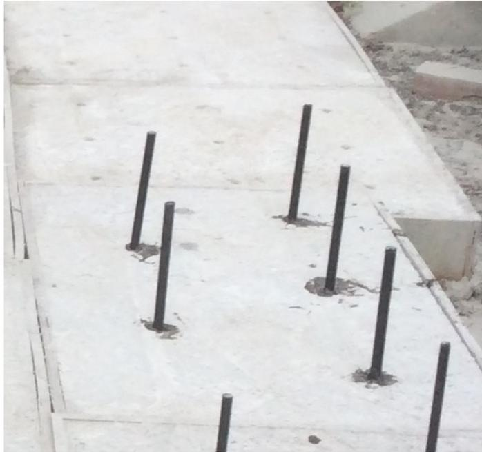
**Figura 12:**Perforación de los primeros anclajes. Fuente: Autor
