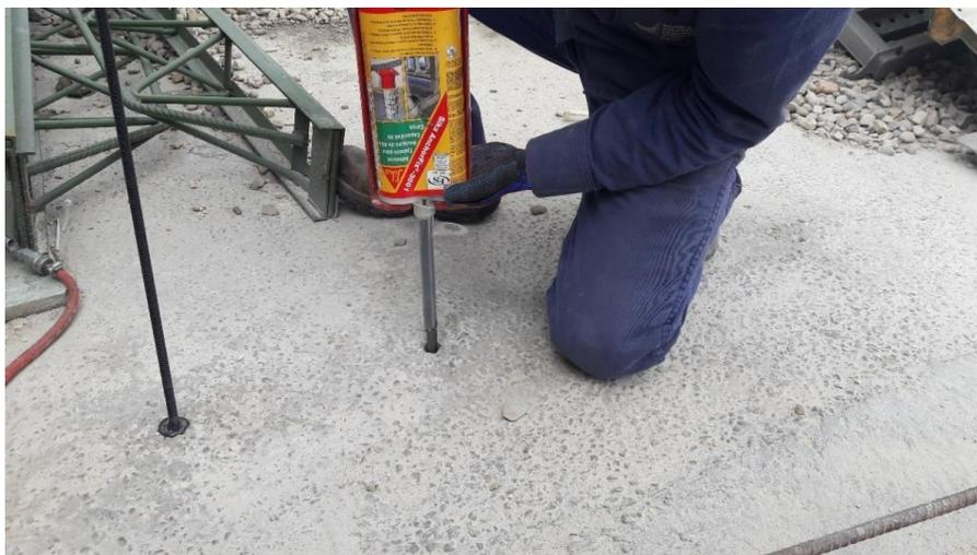
*Figura 17: Inyección del producto epóxico en la perforación. Fuente: Autor.*
