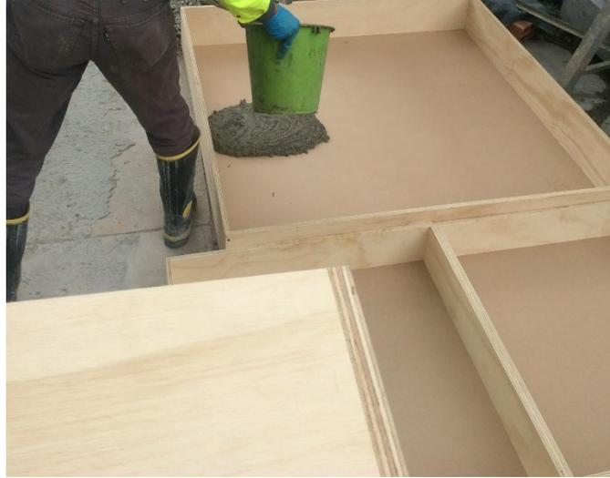
*Figura 7: Formaleta y vaciado del concreto liviano. Fuente: Autor*
