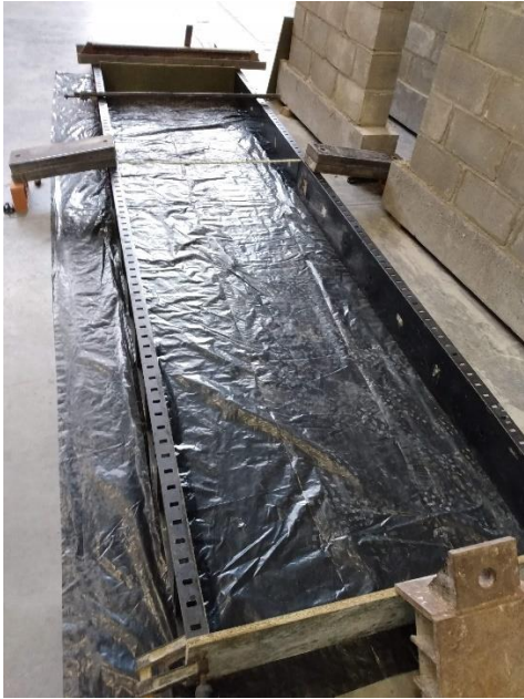
Fotografía No. 1 Armado formaleta metálica
