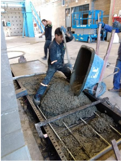
Fotografía No. 3 Vaciado de concreto
