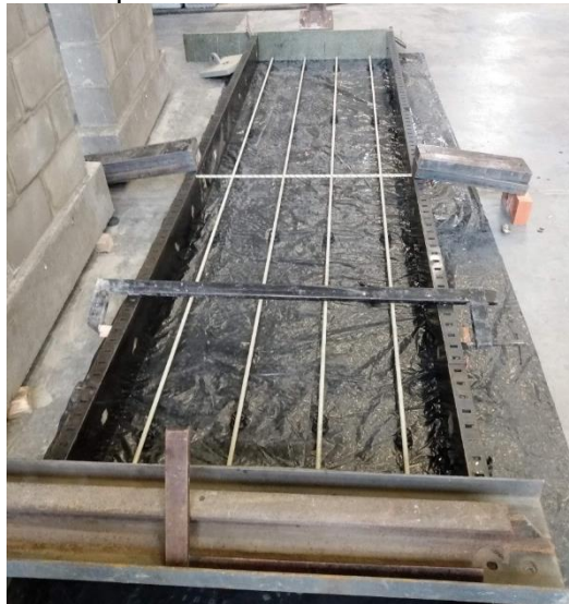
Fotografía B - 8 Disposición de refuerzo elemento LCGFRP-102
