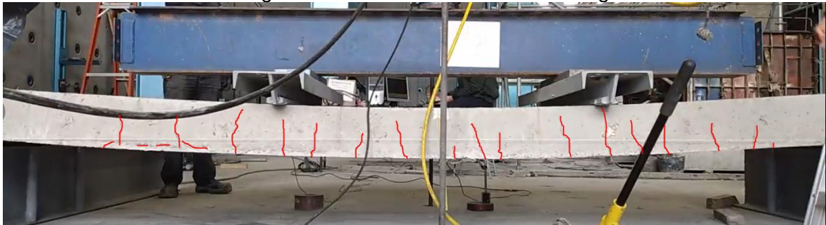
Fotografía E - 13 Fisuras ciclo 3 – 6800 kg
