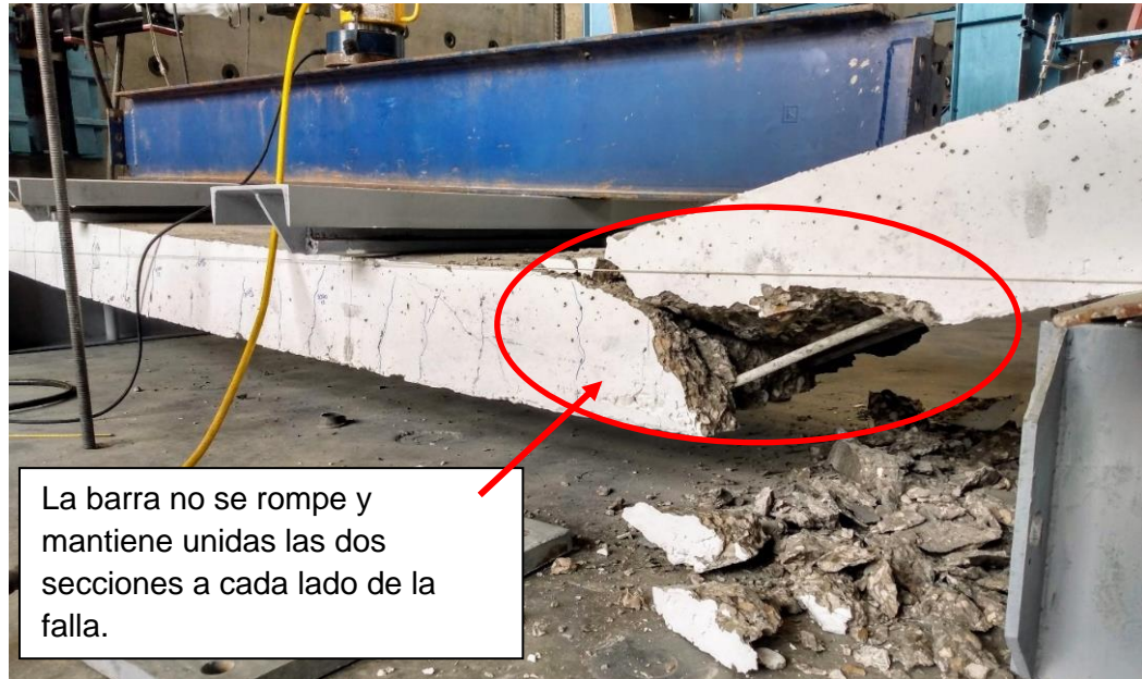
Fotografía No. 9 Falla de elementos LCGFRP 102
