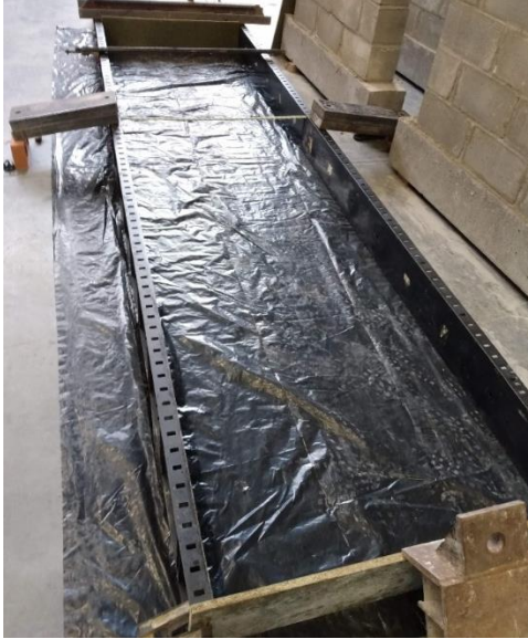
Fotografía B - 5 Formaleta empleada para elaboración de losas
