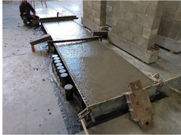
Fotografía No. 4 Elemento finalizado
