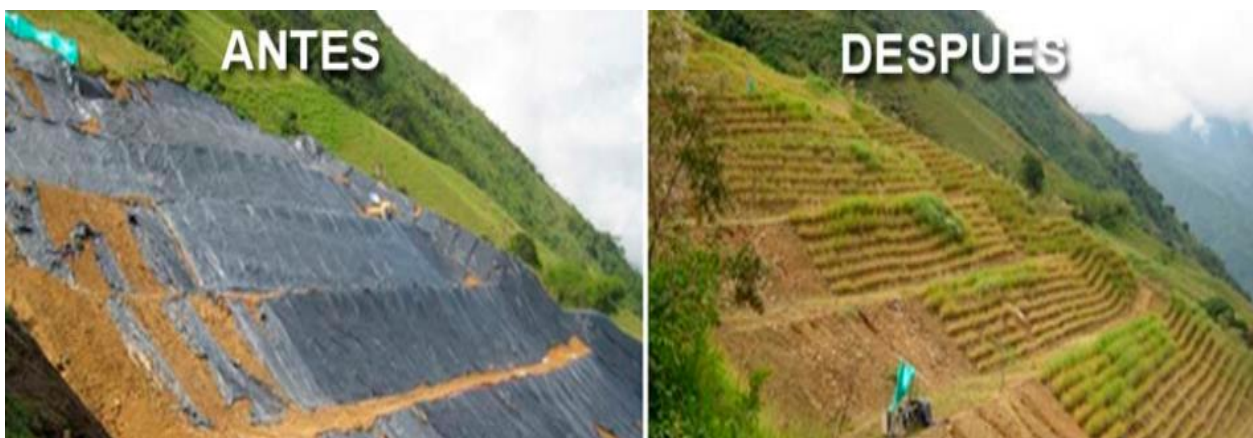
Ilustración 17: Aplicación de la bioingeniería para la restauración de un talud Fuente: (Downs 2013)
