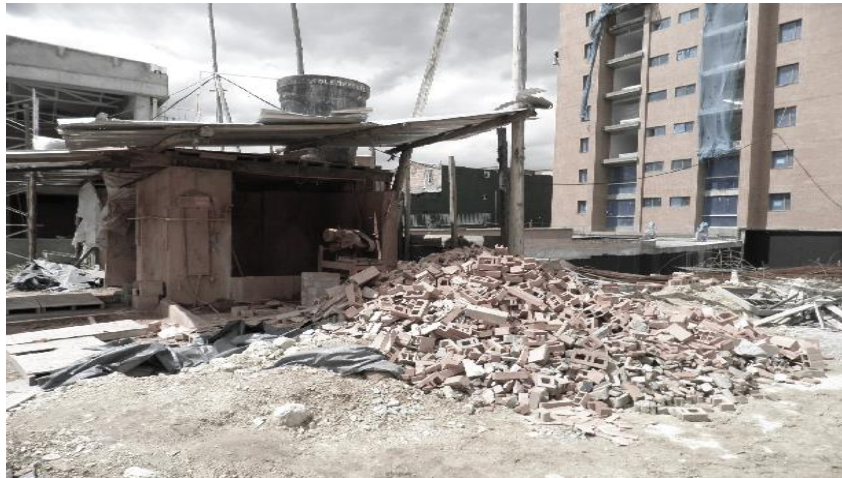
Figura 17. Proyecto edificación de viviendas
